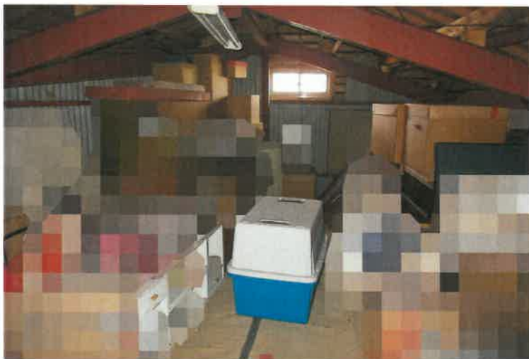
写真21 2階倉庫（増築部分）
