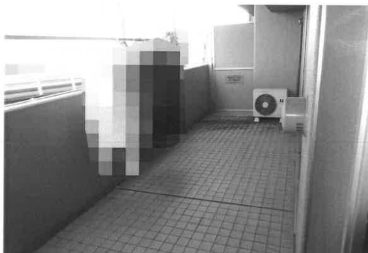
写真16 東側バルコニー
