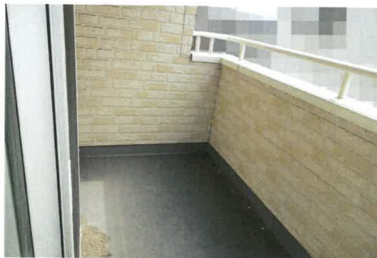
写真21 2階バルコニー
