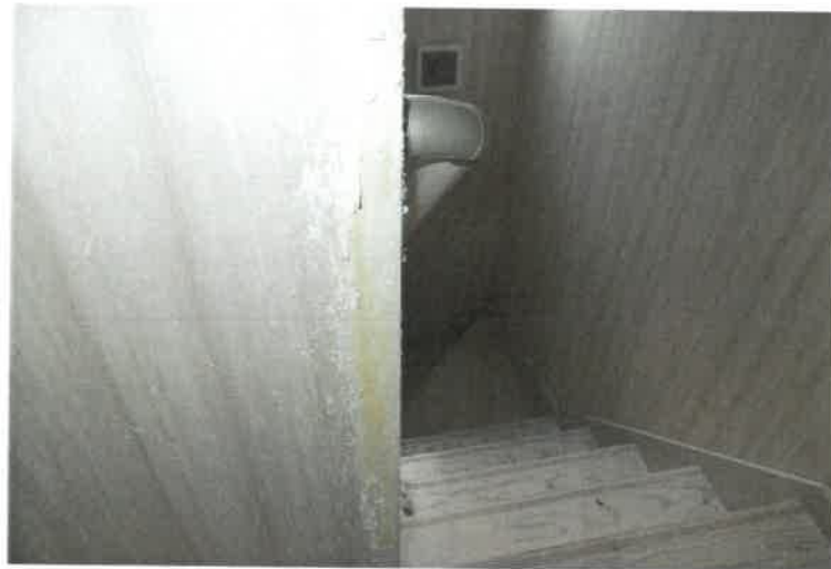
写真19 2階階段・手摺部分
