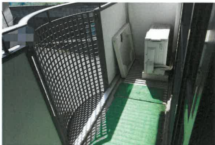
写真 1 7 2 階南西東側ベランダ
