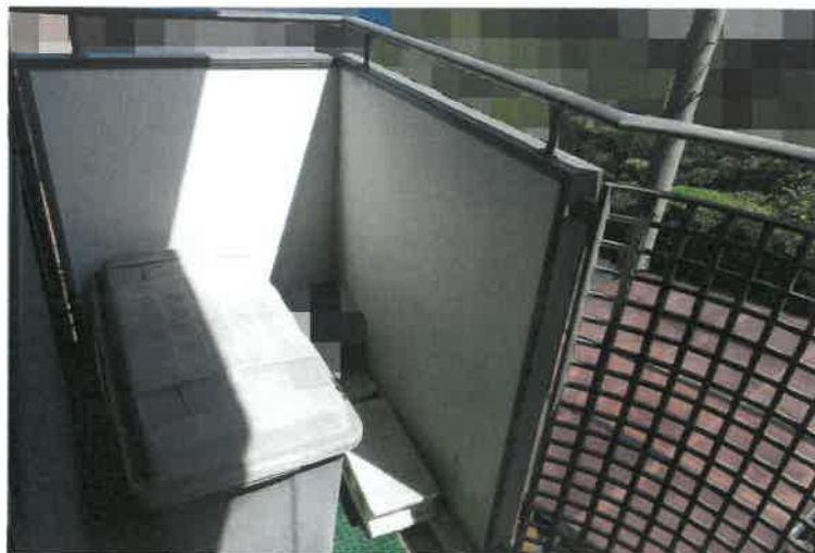
写真 1 6 2 階南東側ベランダ
