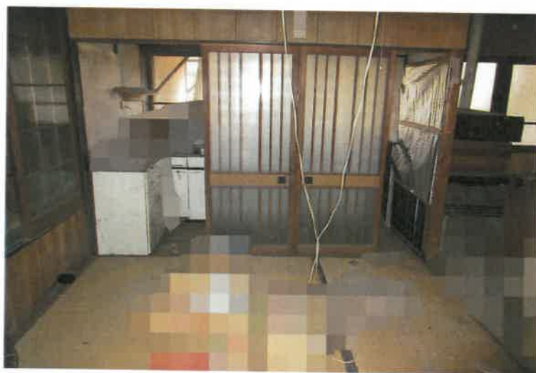
写真8 主建物・北東側土間
