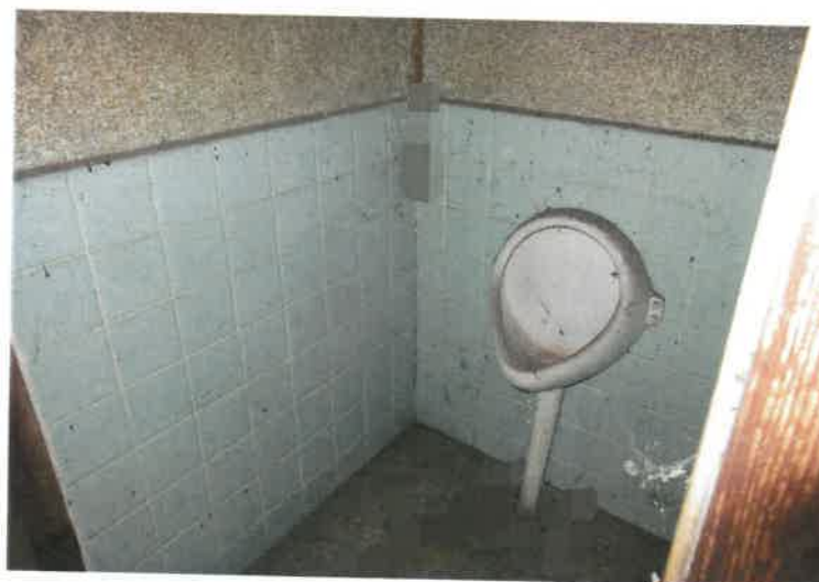
写真 2 7 附属建物符号 4 ・男性用トイレ
