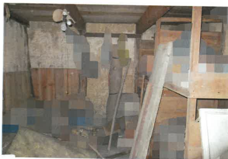
写真 2 3 附属建物符号 4 ・中央側物置
