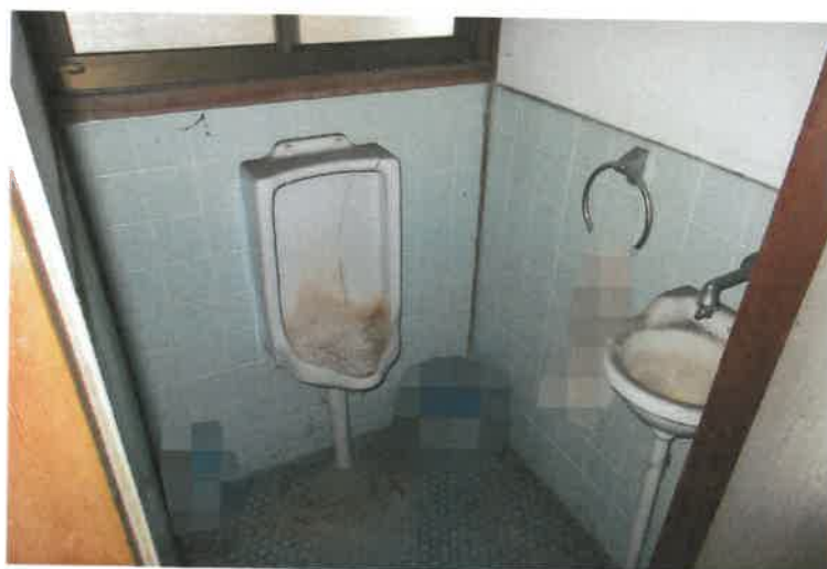
写真17 主建物・男性用トイレ
