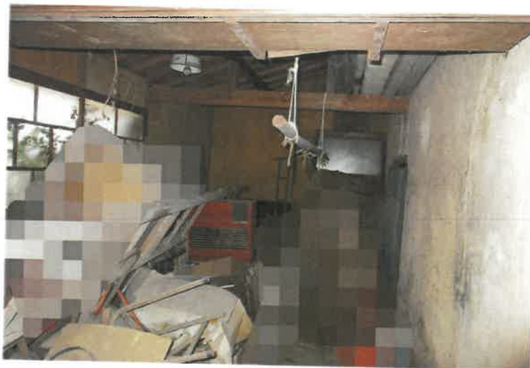
写真 2 5 附属建物符号 4 ・北側物置
