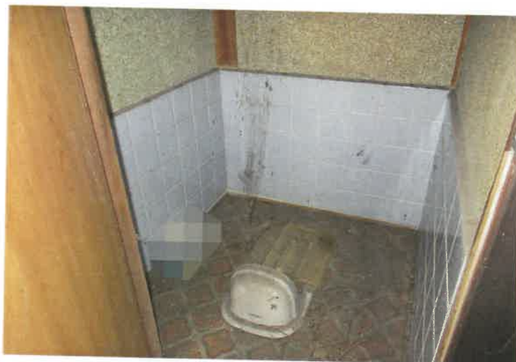
写真 2 6 附属建物符号 4 ・トイレ
