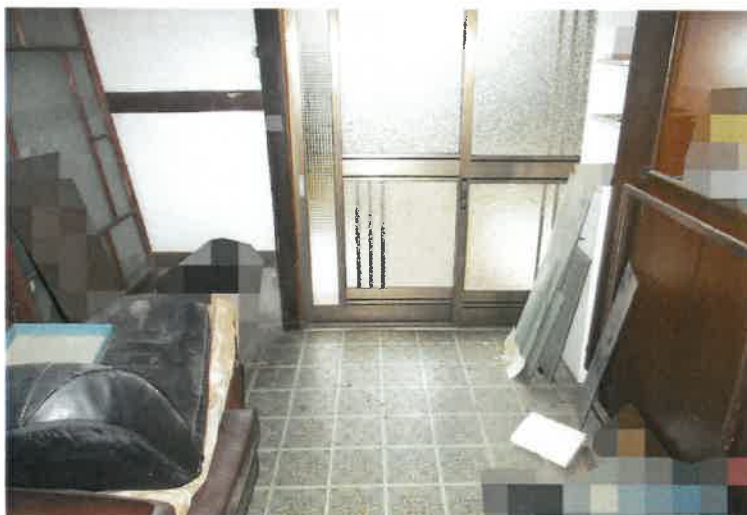
写真6 主建物・玄関土間
