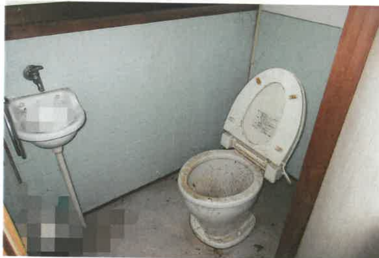
写真18 主建物・トイレ
