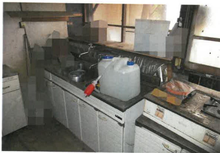
写真9 主建物・台所
