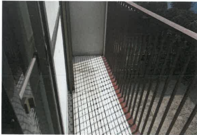
写真16 2階バルコニー
