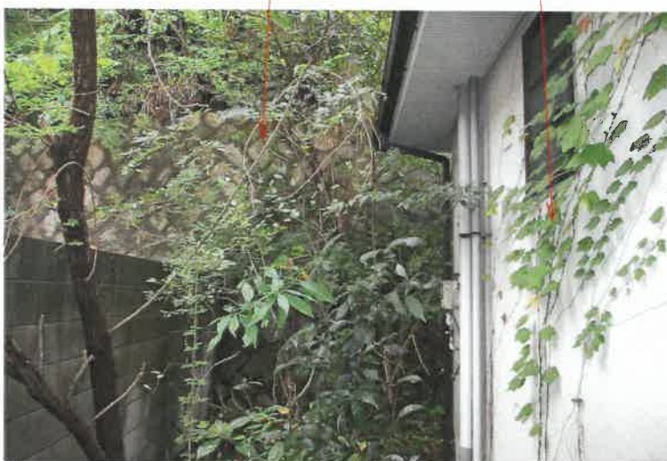
写真5 法面 物件4主建物
