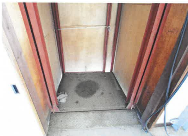
写真1 5 (物件5 符号1 附属建物2 階リフト)
