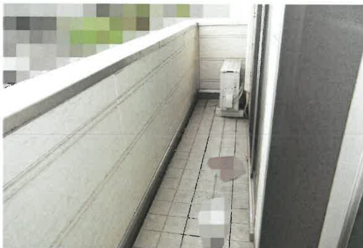
写真16 2階バルコニー
