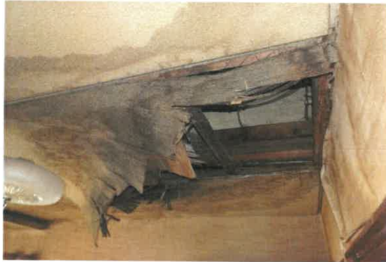
写真 2 5 1 階天井の状況
