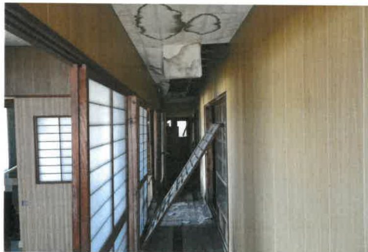
写真 2 7 1 階天井の状況
