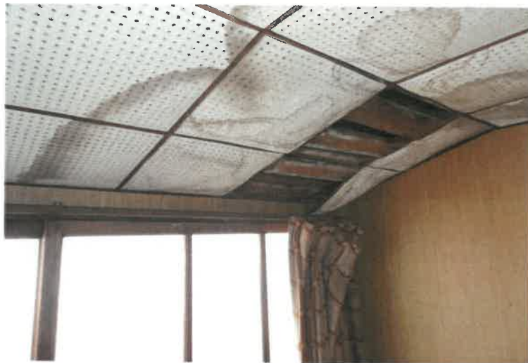
写真 2 6 1 階天井の状況
