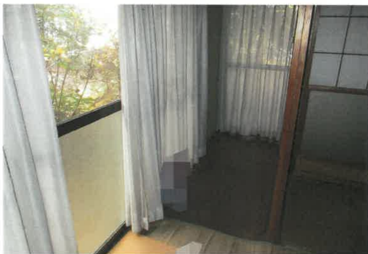
写真1 4 主建物・南西側縁
