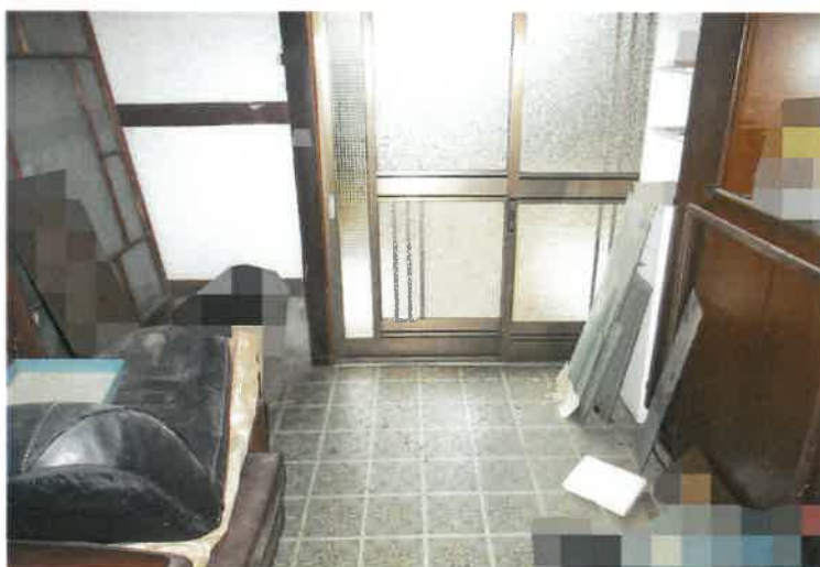
写真6 主建物・玄関土間
