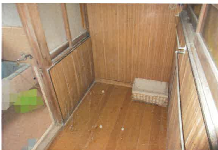
写真 2 0 附属建物符号 1 ・脱衣所
