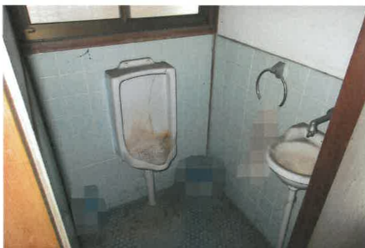
写真17 主建物・男性用トイレ
