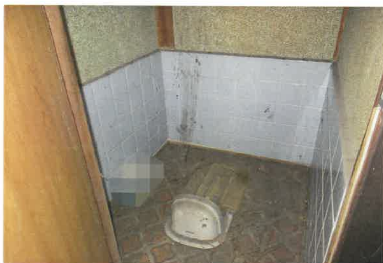
写真 2 6 附属建物符号 4 ・トイレ
