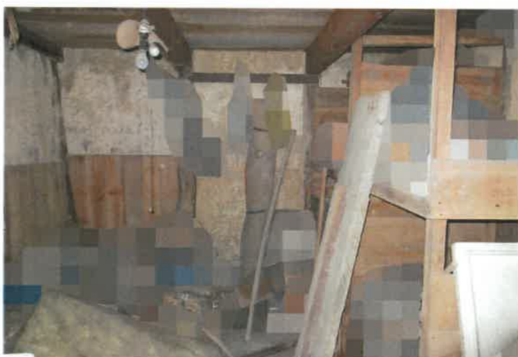
写真 2 3 附属建物符号 4 ・中央側物置
