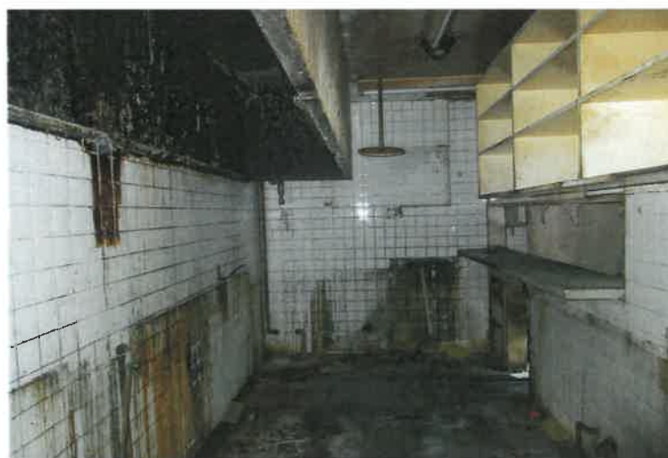
写真 1 1 物件 2 建物・東側厨房
