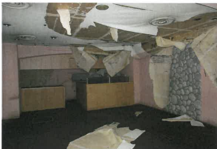
写真8 物件1、2建物・店舗部分
