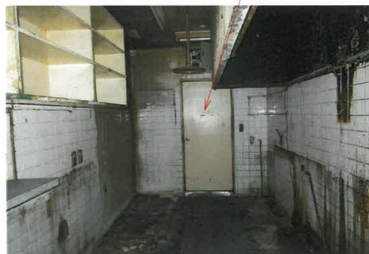
写真 1 2 物件 2 建物・東側厨房 入り口部分
