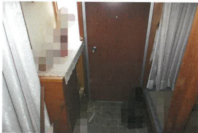
写真 2 3 物件 3 建物・玄関
