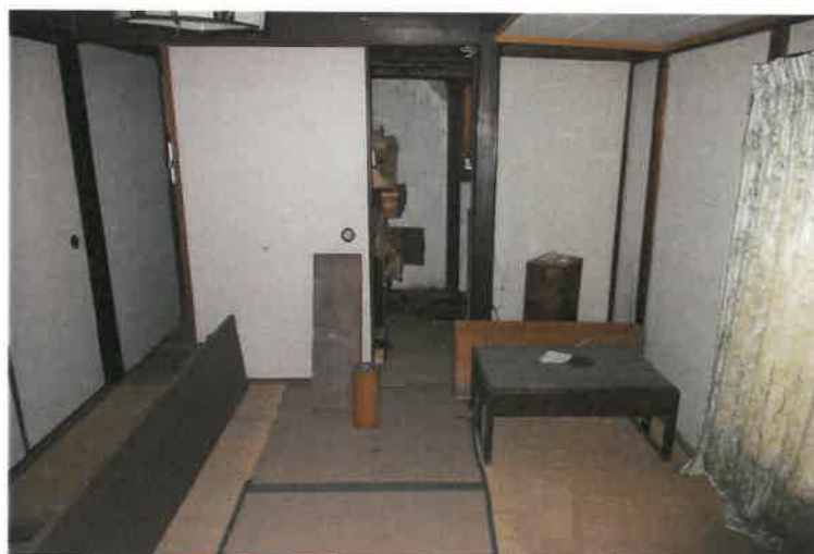
写真18 物件2建物・北西側和室4.5畳
