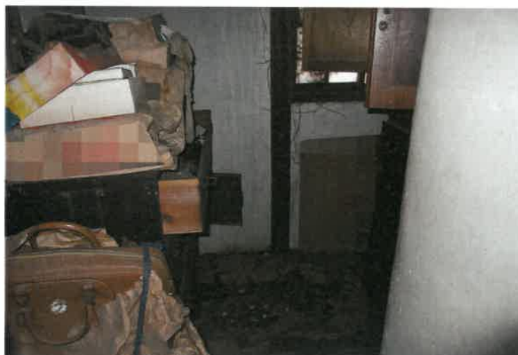
写真21 物件2建物・北西側物置
