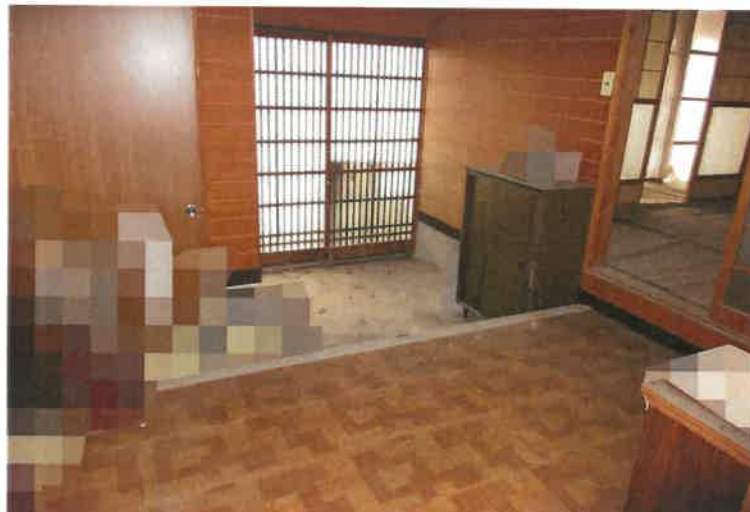
写真12 物件2建物・小上がり・玄関
