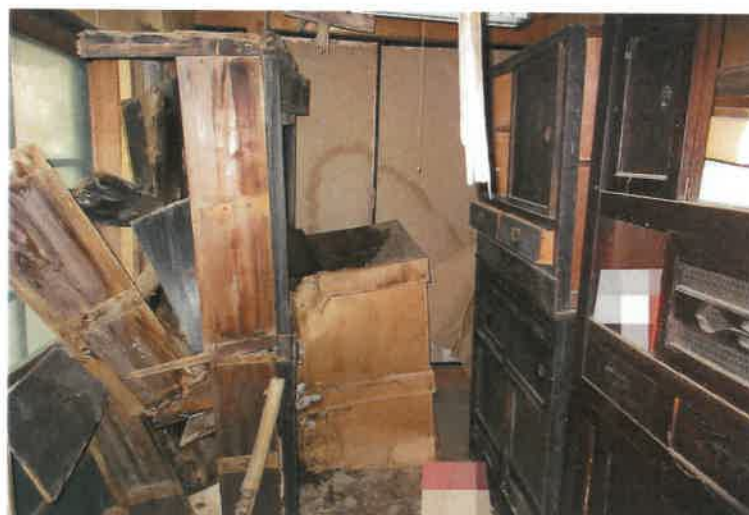
写真1 5 物件2建物・小上がり東側物置
