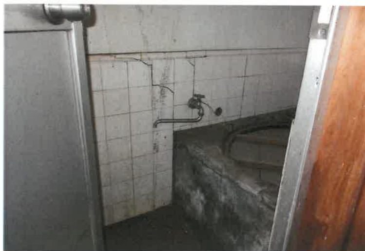
写真9 物件2建物・浴室
