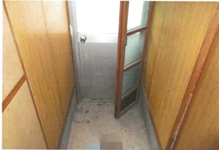
写真28 物件3建物・勝手口
