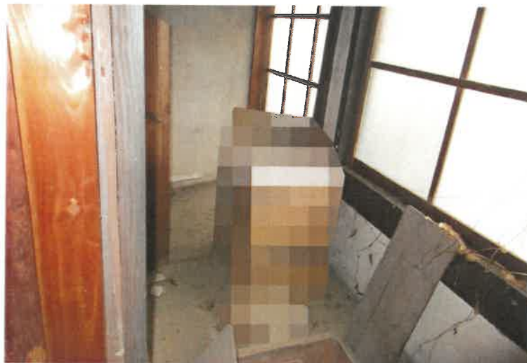
写真1 3 物件2建物・玄関東側物置
