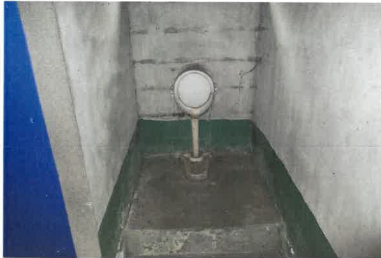
写真7 1階男性用トイレ
