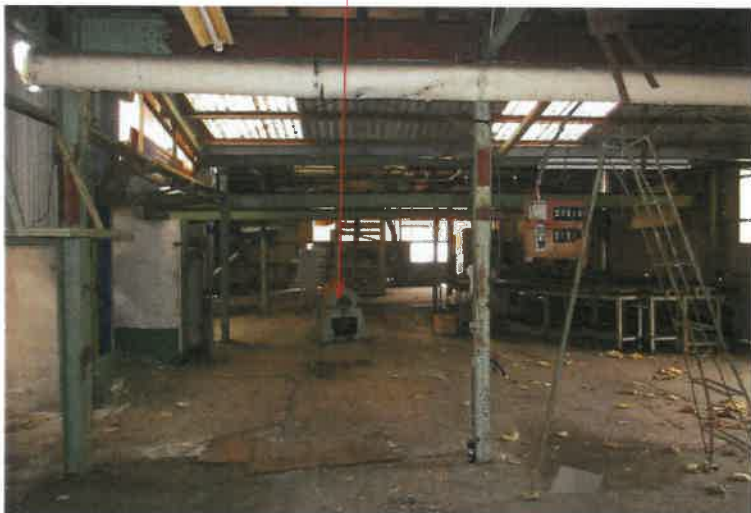
写真9 1階中央部分 材料送り機
