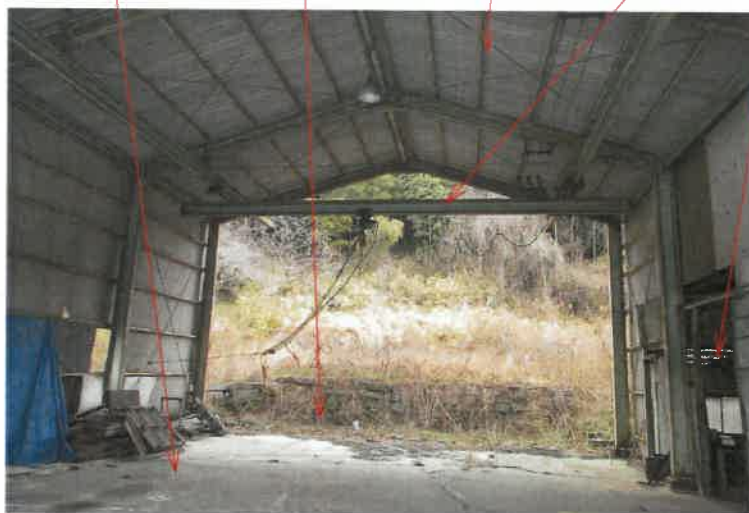
写真4 物件1 土地 隣地(1046-2) 構築物 1 トンボイスト 物件2 建物
