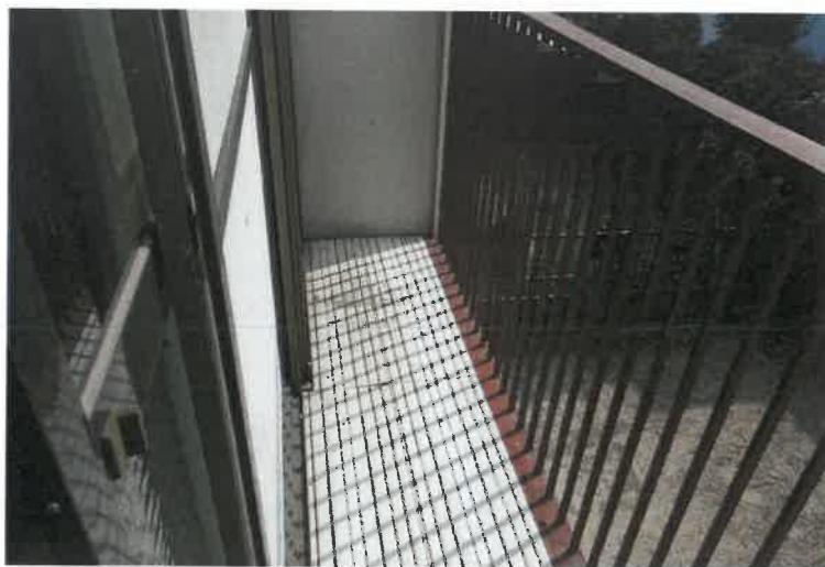
写真16 2階バルコニー
