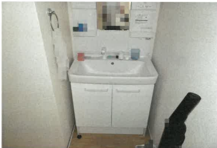
写真14 102号室内の状況
