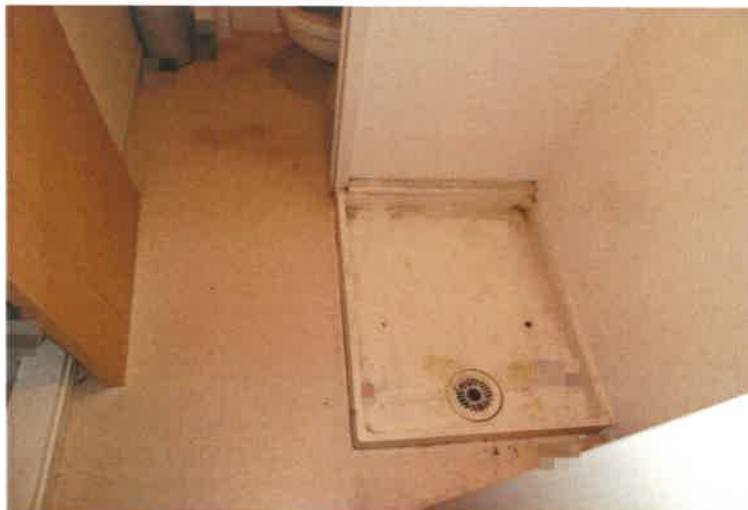
写真15 102号室内の状況
