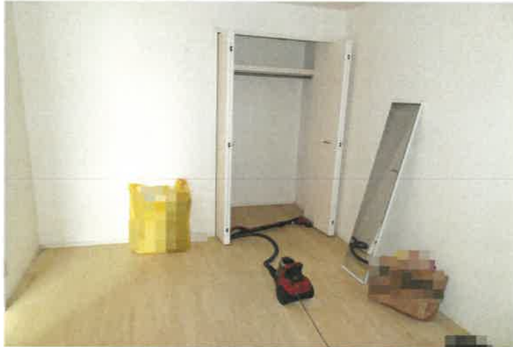
写真13 102号室内の状況
