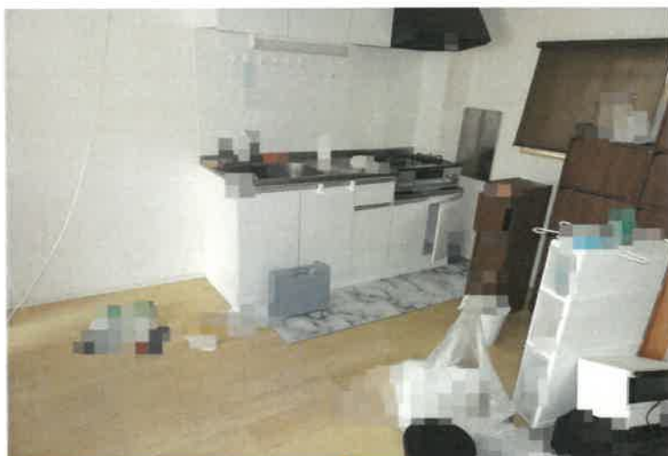
写真11 102号室内の状況
