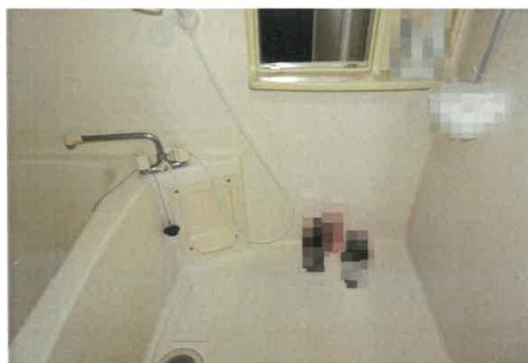
写真２４ ２０１号室内の状況
