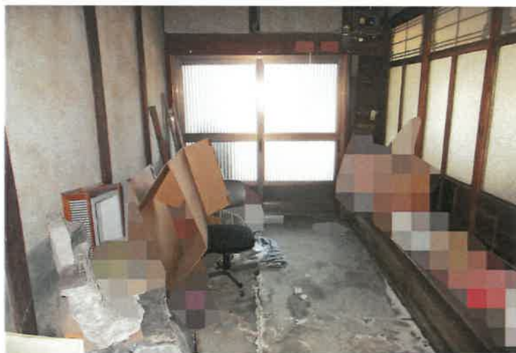
写真1 4 物件6 附属建物符号1・1階土間
