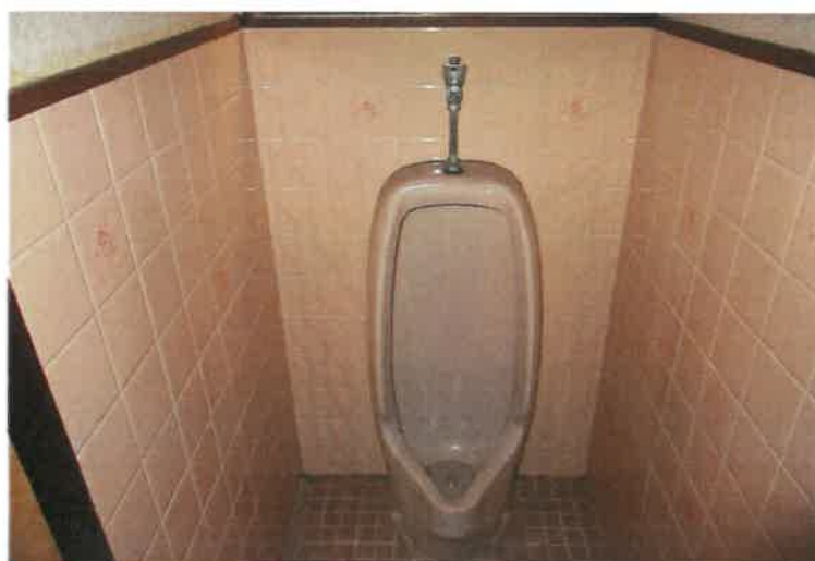
写真6 物件6主建物・1階男性用トイレ
