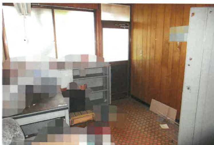
写真 2 3 物件 7 建物 ・ 1 階南西側洋室
