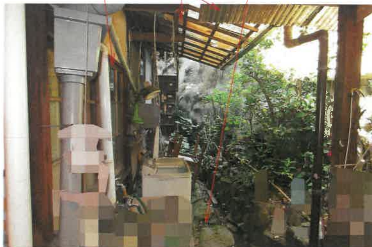
写真4 物件6主建物 下屋 物件3土地
