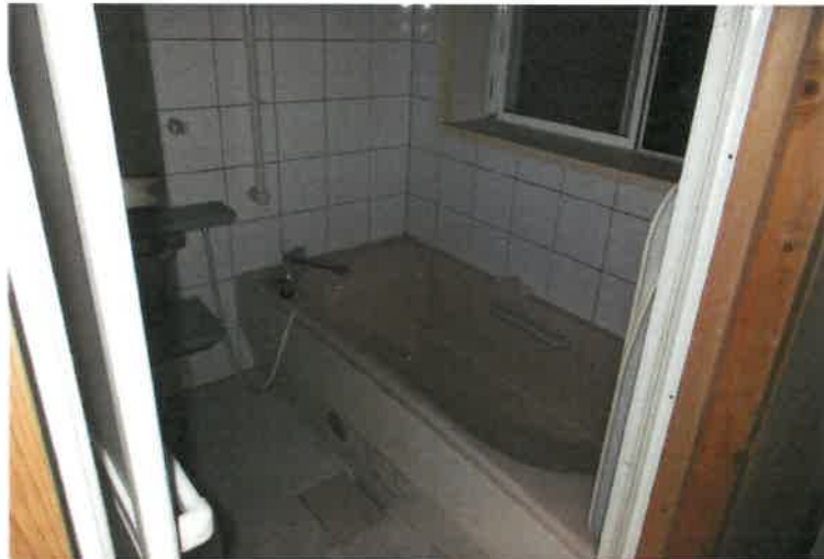
写真8 物件6主建物・1階浴室
