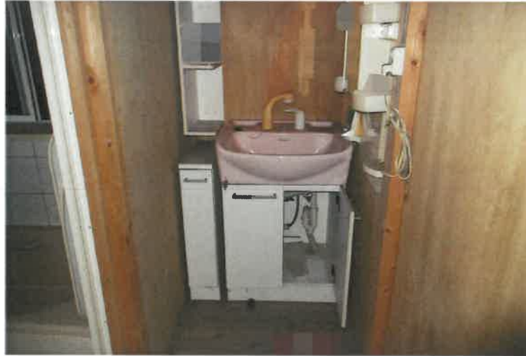
写真7 物件6主建物・1階洗面・脱衣室
