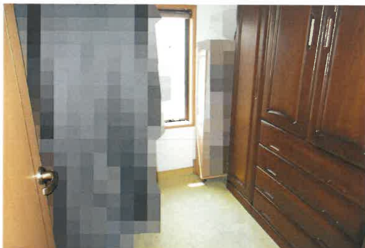
写真25 3階小屋裏収納1
