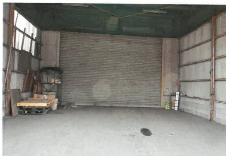
写真5 物件2建物・1階北側未登記増築部分
