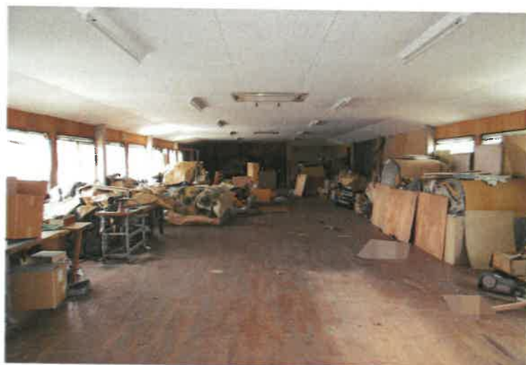
写真18 物件4建物・2階作業場・倉庫
