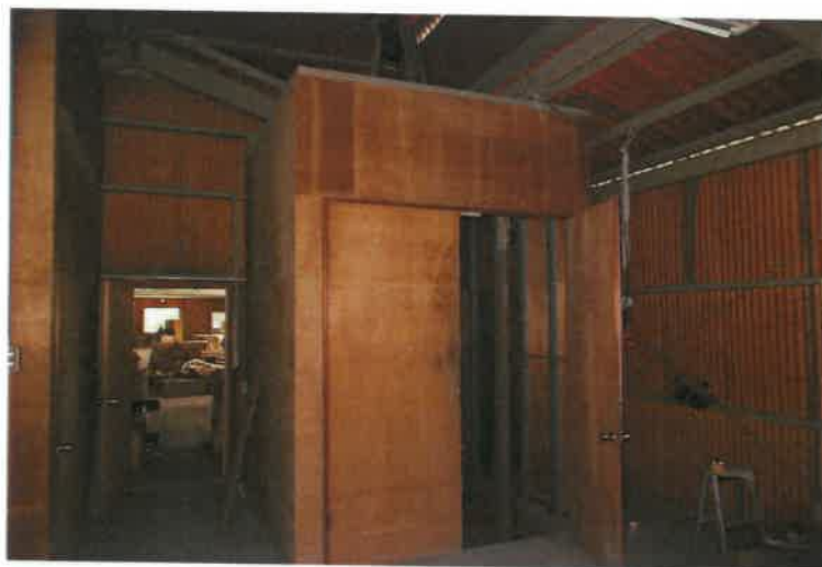
写真9 物件2建物・2階倉庫（リフト）
