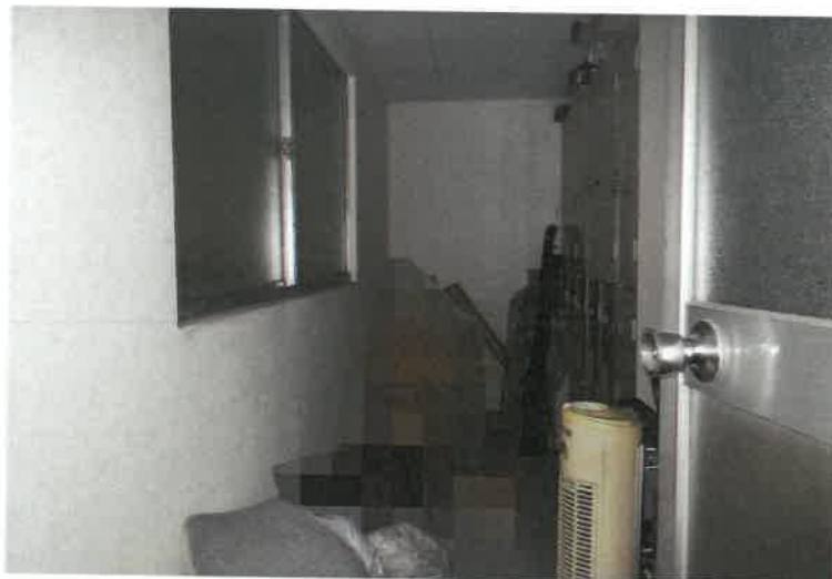
写真16 物件4建物・中2階倉庫
