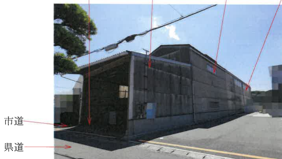
写真2 物件1土地 未登記増築部分 物件2建物 物件4建物
