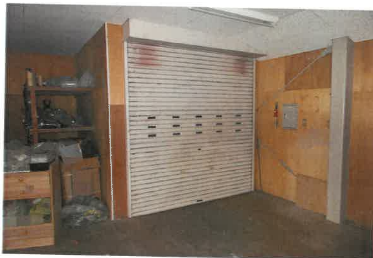
写真 1 9 物件 4 建物・2 階作業場・倉庫（リフト）
