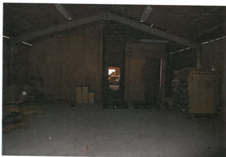
写真8 物件2建物・2階倉庫
