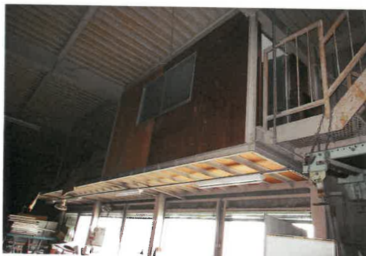
写真1 5 物件4建物・中2階倉庫
