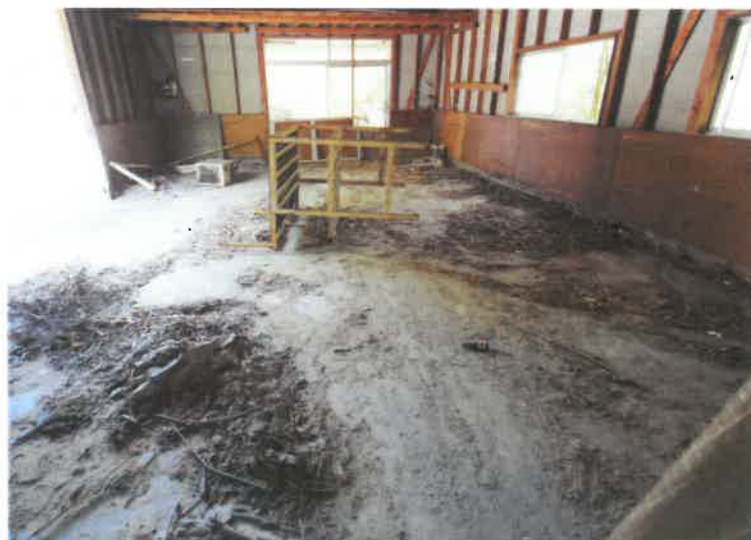
写真 1 2 (物件 2 建物東側作業所)
