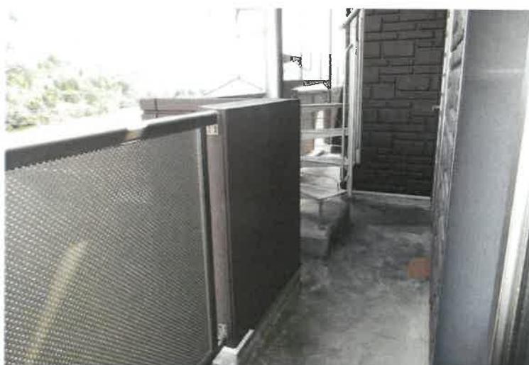
写真17 2階バルコニー
