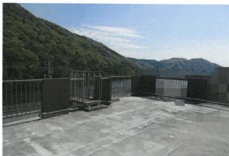
写真18 屋上バルコニー
