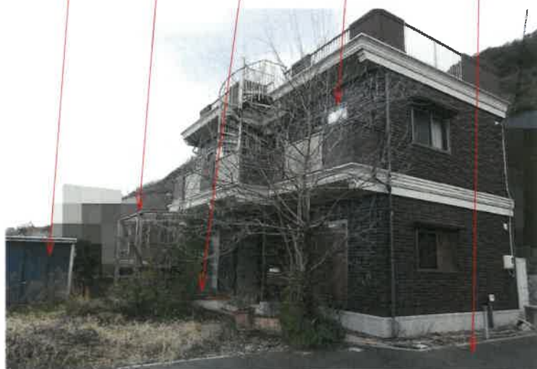
写真3 簡易物置 下屋 ウッドデッキ 物件2建物 物件1土地
