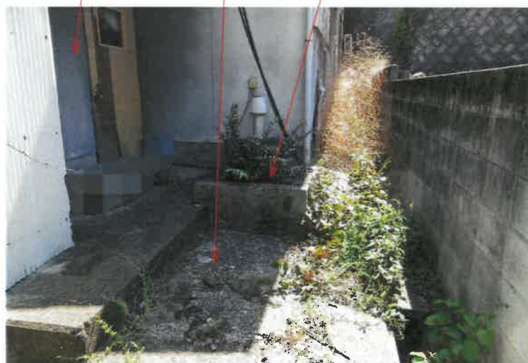
写真5 物件2建物 物件1土地 井戸
