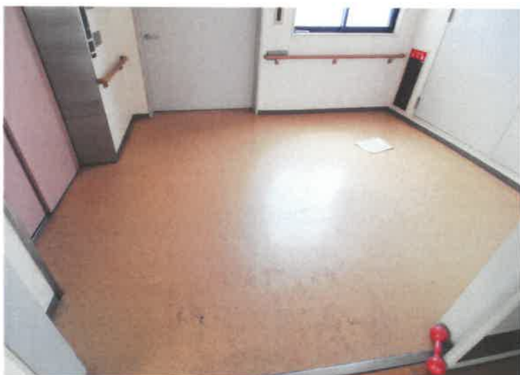
写真 2 4 （3階エレベーターホール）
