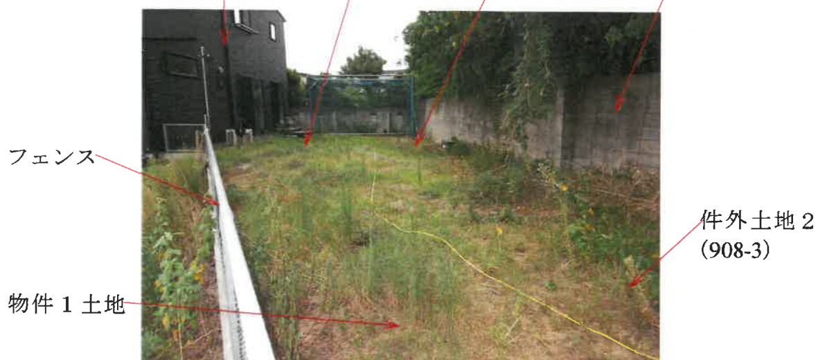
写真6 物件3建物 物件2土地 件外土地1 (906) ブロック塀
