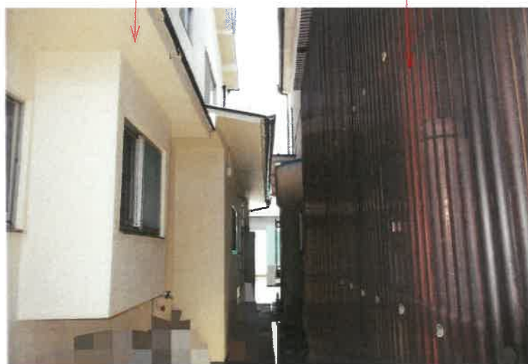
写真3 隣家 物件2 建物
