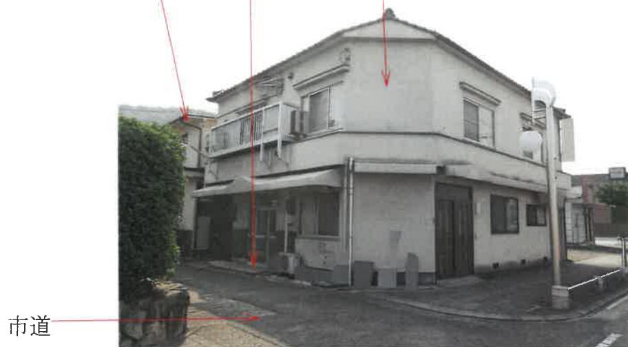
写真1 隣家 物件1 土地 物件2 建物
