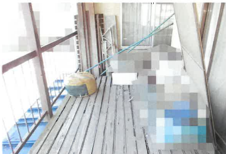
写真 2 3 2 階北西側ベランダ
