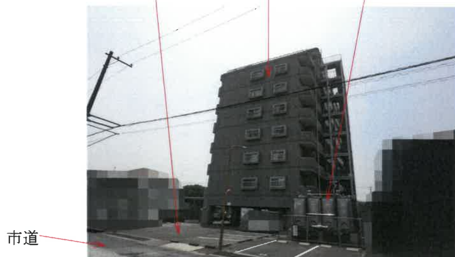
写真3 符号1の土地 本件一棟の建物 受水槽
