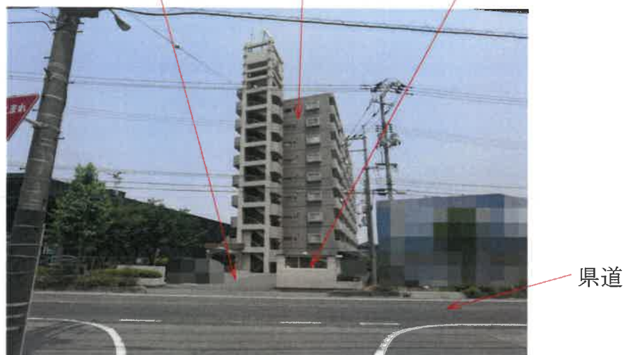
写真1 符号1の土地 本件一棟の建物 ゴミ置場
