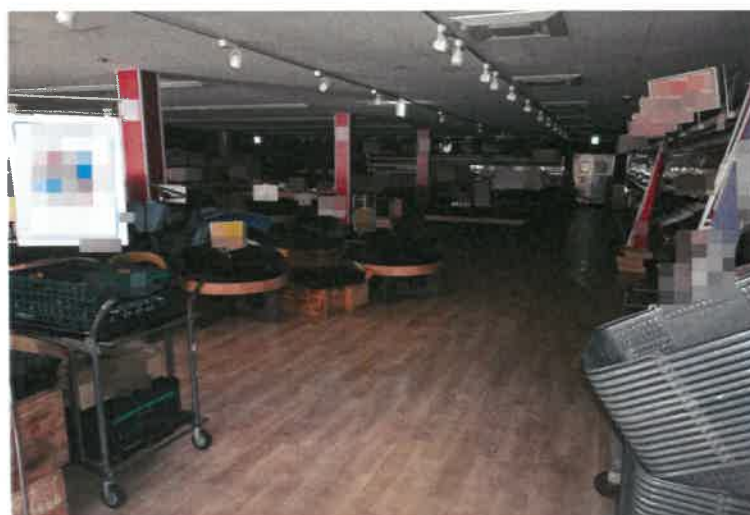
写真9 物件2の建物内の状況
