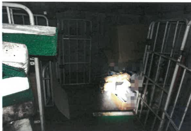
写真 4 5 物件 3 の附属建物符号 1 内の状況
