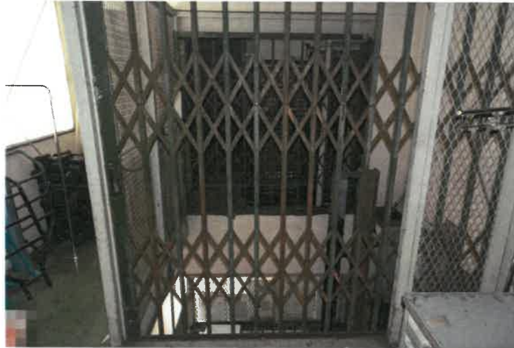
写真 4 3 物件 3 の附属建物符号 1 内の状況
