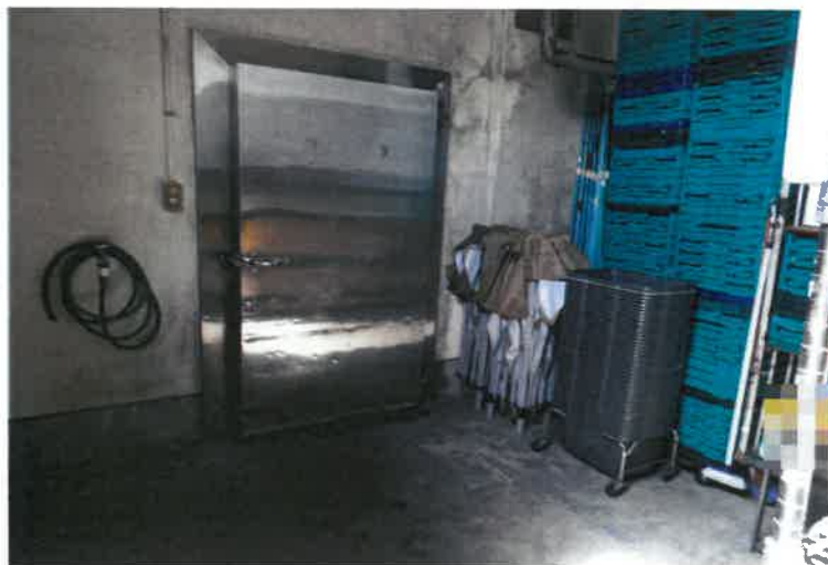
写真 4 2 物件 3 の附属建物符号 1 内の状況
