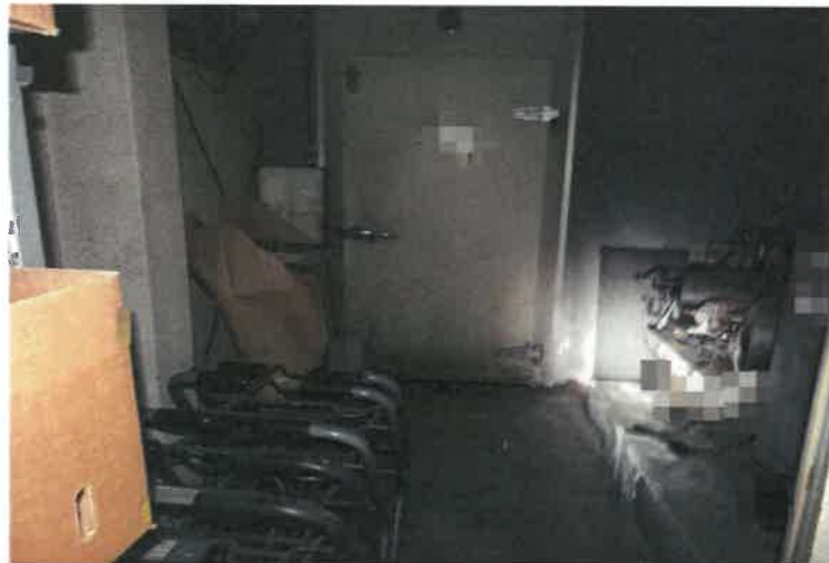
写真 4 4 物件 3 の附属建物符号 1 内の状況
