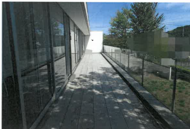
写真 2 8 2 階ルーフテラス
