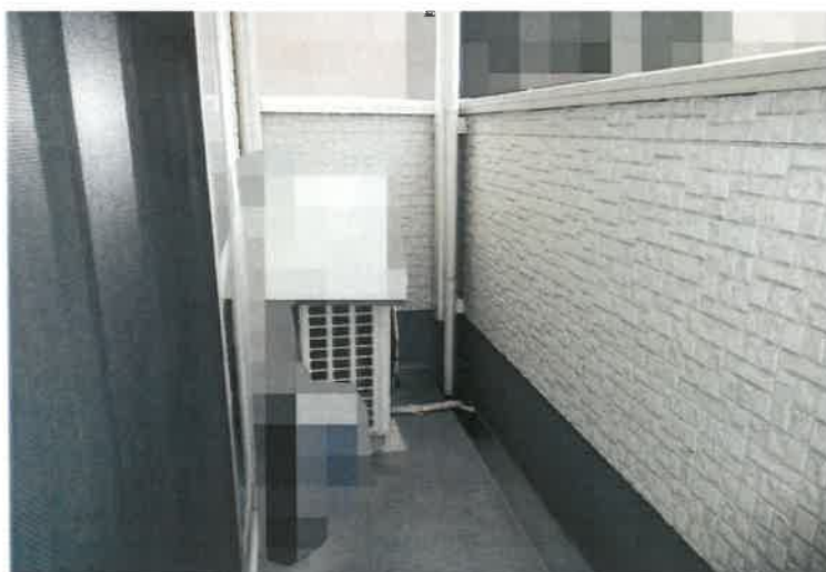
写真1 5 2階バルコニー
