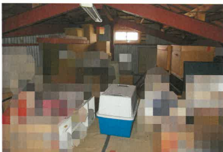
写真21 2階倉庫（増築部分）
