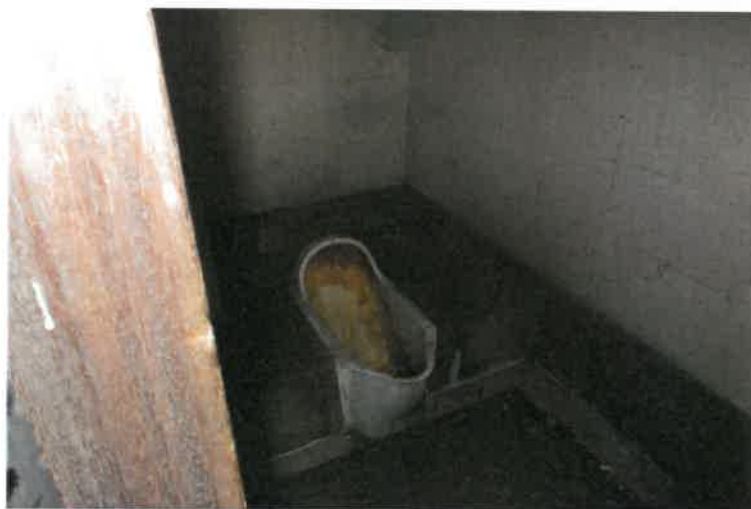
写真20 物件3建物・1階トイレ
