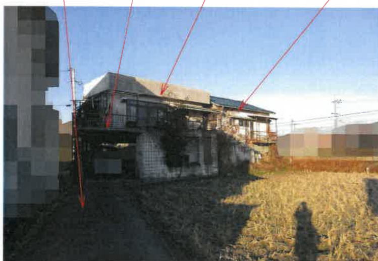
写真2 物件1 土地 下屋 物件2 附属建物 物件2 主建物
