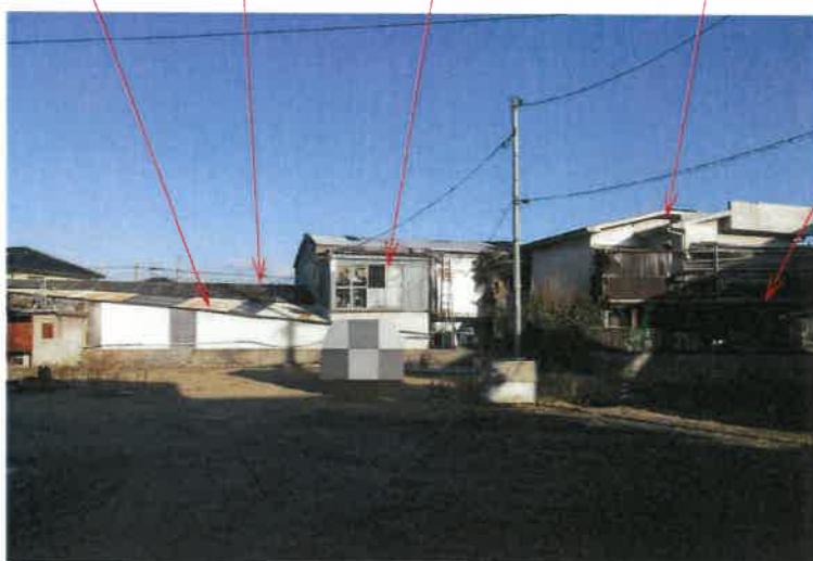
写真3 下屋 物件3 建物 未登記増築部分 物件2 附属建物 下屋
