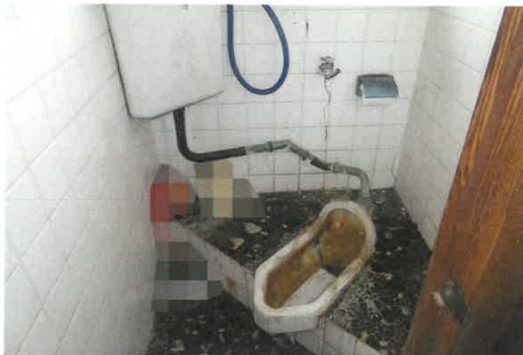
写真7 物件2主建物・2階トイレ
