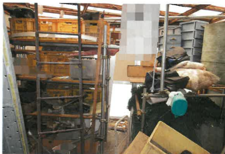
写真 2 4 物件 3 建物・2 階未登記増築部分
