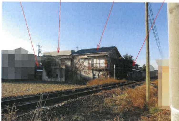
写真4 下屋 物件2 附属建物 物件2 主建物 物件3 建物
