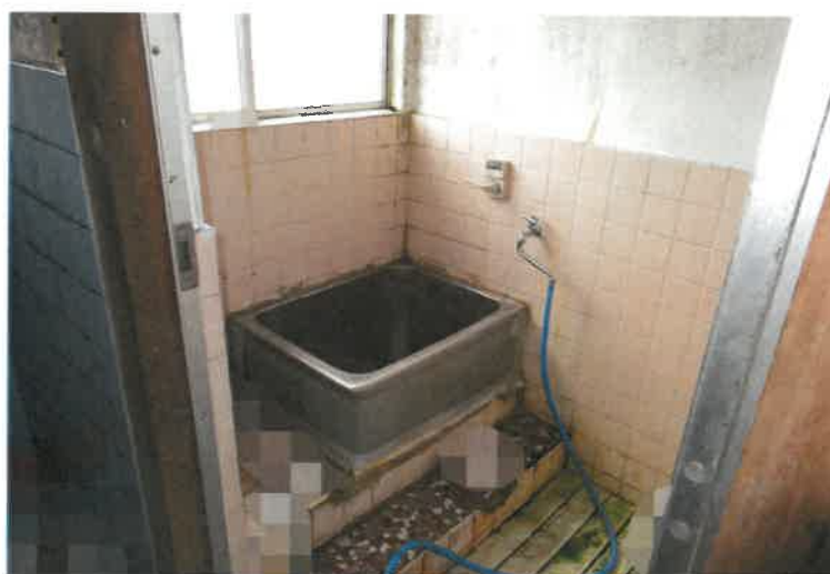
写真8 物件2主建物・2階浴室
