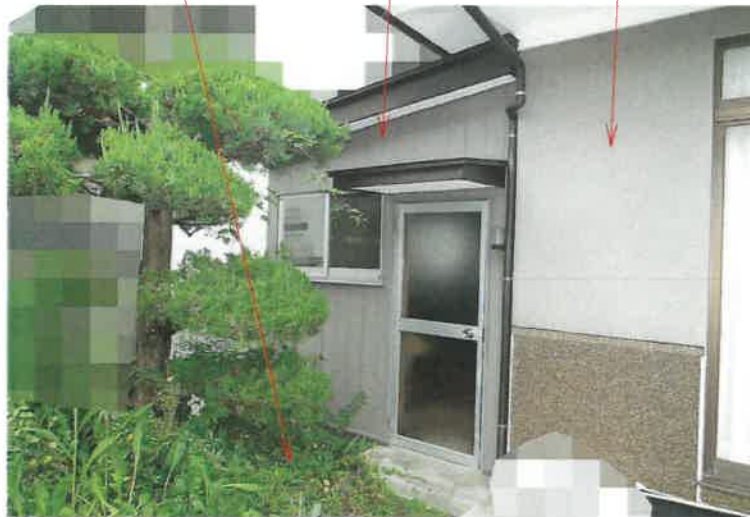
写真4 物件1 土地 未登記増築部分 物件2 建物
