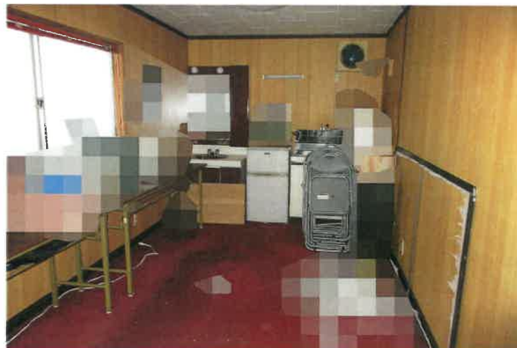
写真18 1階洋室（未登記増築部分）
