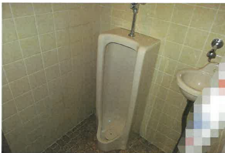
写真8 1階男性用トイレ
