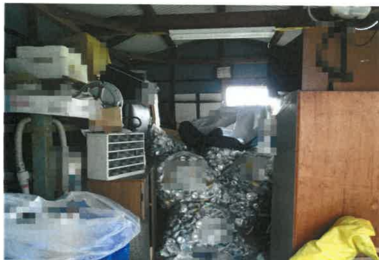
写真 1 5 附属建物符号 1 内の状況
