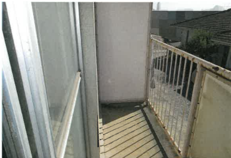
写真3 5 物件3建物・3号室・2階バルコニー
