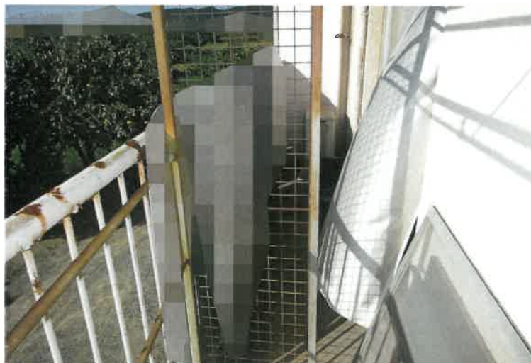
写真27 物件3建物・2号室・2階バルコニー
