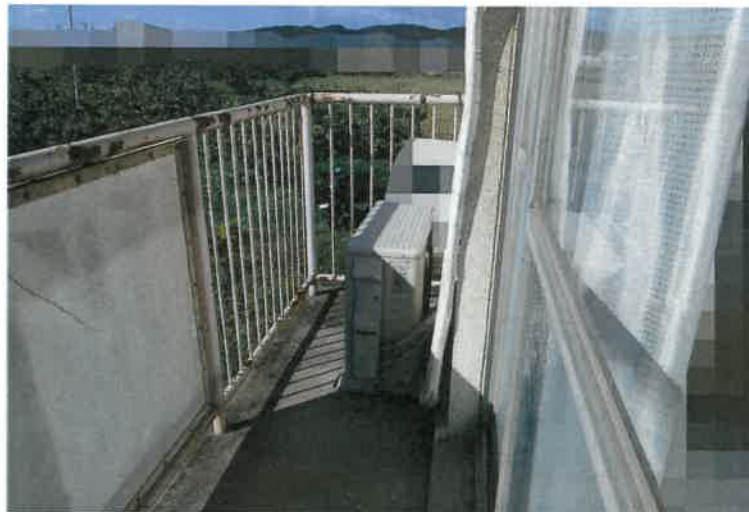
写真4 4 物件3建物・4号室・2階バルコニー
