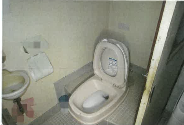
写真37 物件3建物・4号室・1階トイレ
