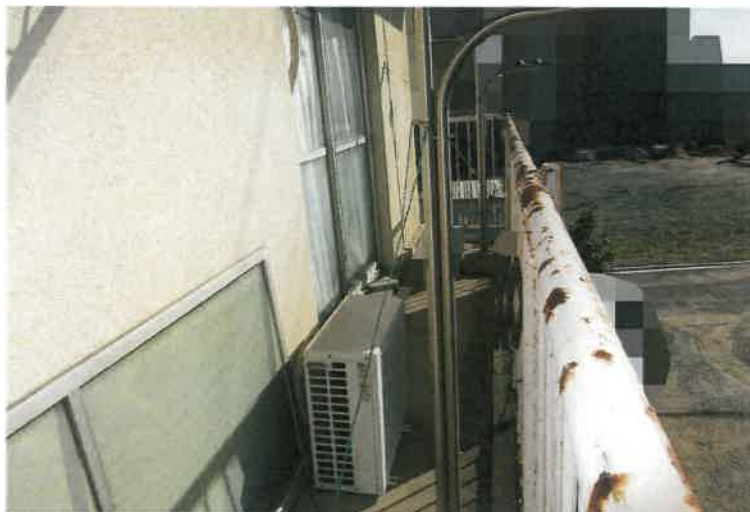
写真18 物件3建物・1号室・2階バルコニー
