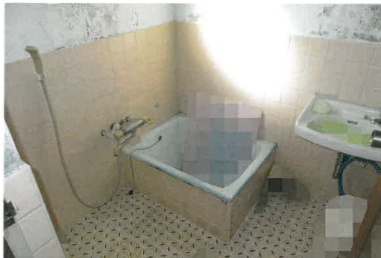
写真10 物件3建物・1号室・1階浴室
