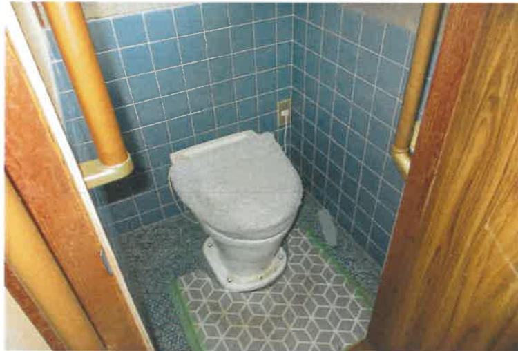
写真7 主建物・1階トイレ
