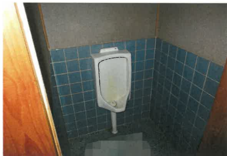
写真6 主建物・1階男性用トイレ
