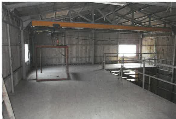
写真 1 3 物件 5 建物・2 階倉庫
