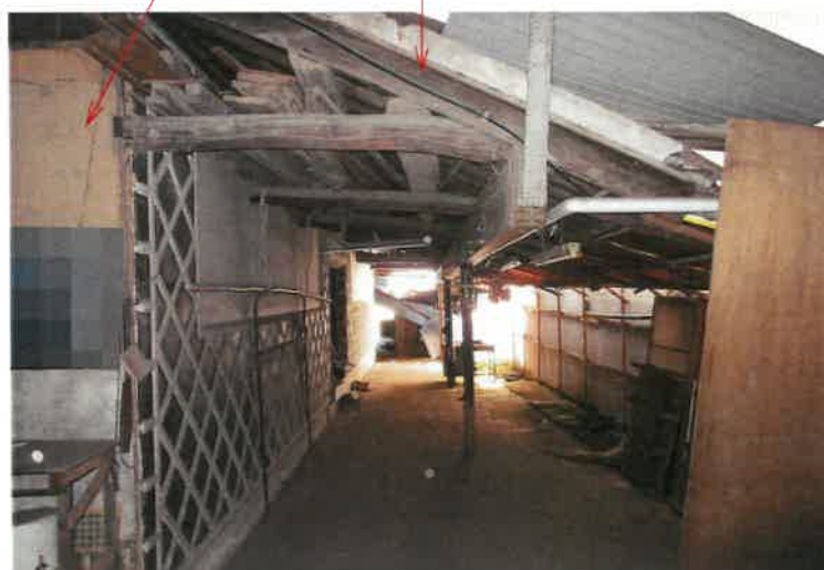
写真6 物件4主建物 下屋状物置
