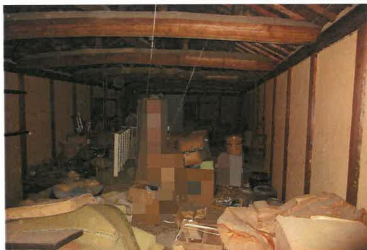
写真8 物件4主建物・2階倉庫
