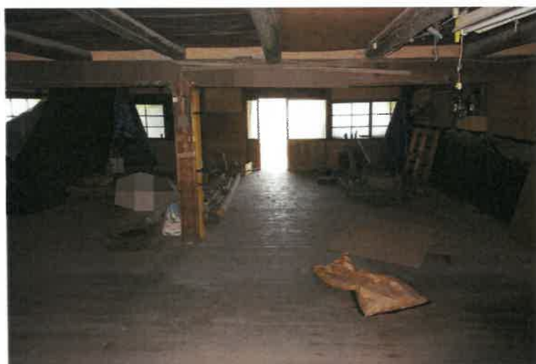
写真9 物件4附属建物・作業場
