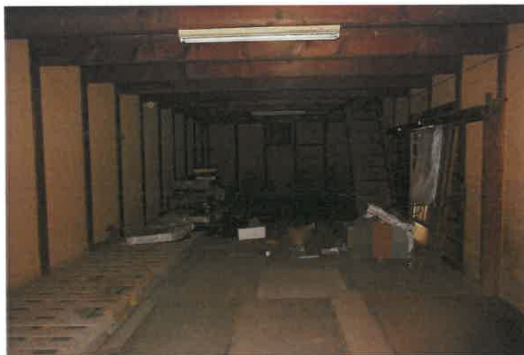
写真7 物件4主建物・1階倉庫
