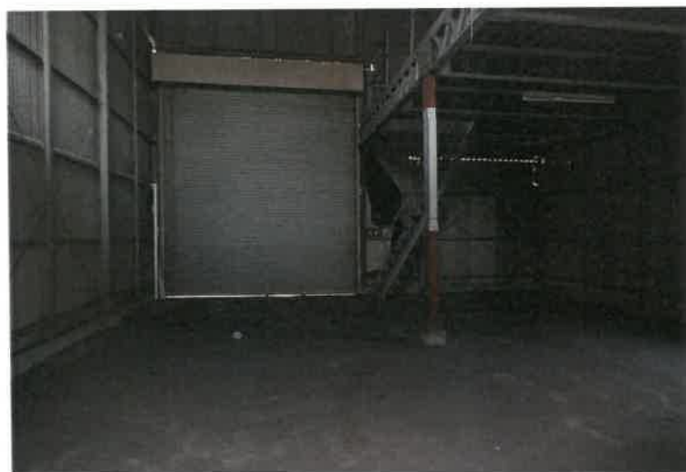
写真12 物件5建物・1階倉庫
