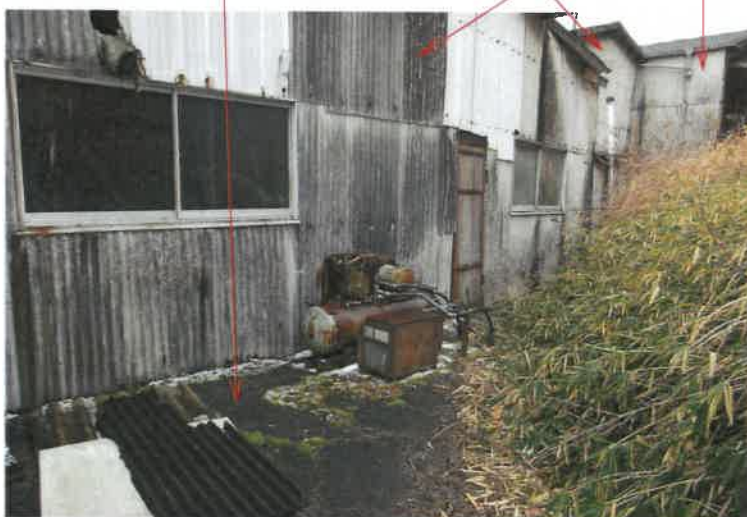
写真5 物件1 土地 物件2 建物 構築物
