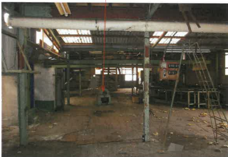
写真9 1階中央部分 材料送り機
