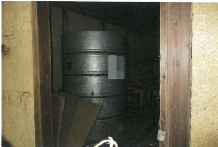
写真 2 4 目的外未登記建物内
