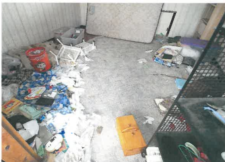
写真12 (2階南西側洋室)
