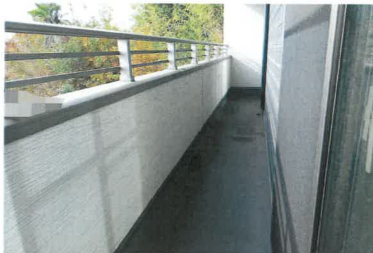
写真19 物件2建物・2階バルコニー
