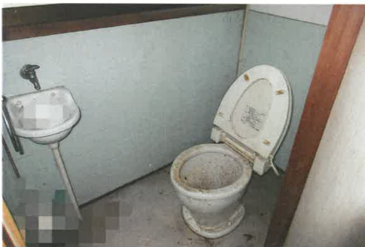
写真18 主建物・トイレ
