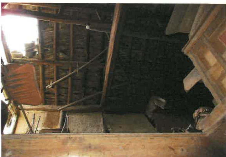
写真 2 4 附属建物符号 4 ・中央側物置（屋根部分）
