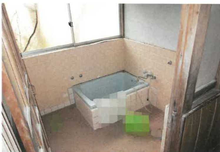
写真21 附属建物符号1・浴室
