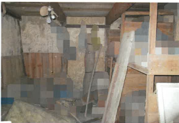
写真 2 3 附属建物符号 4 ・中央側物置
