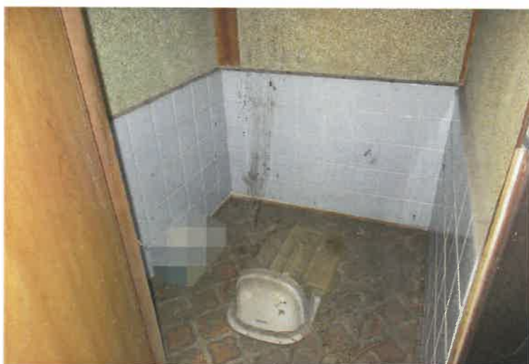
写真26 附属建物符号4・トイレ
