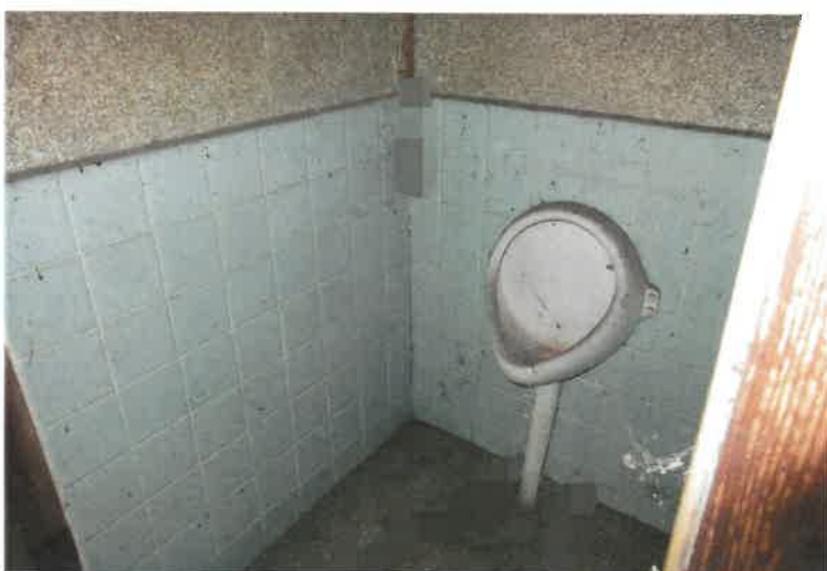
写真27 附属建物符号4・男性用トイレ
