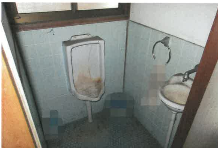
写真17 主建物・男性用トイレ
