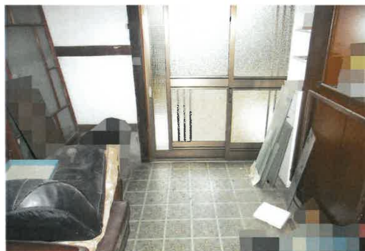
写真6 主建物・玄関土間
