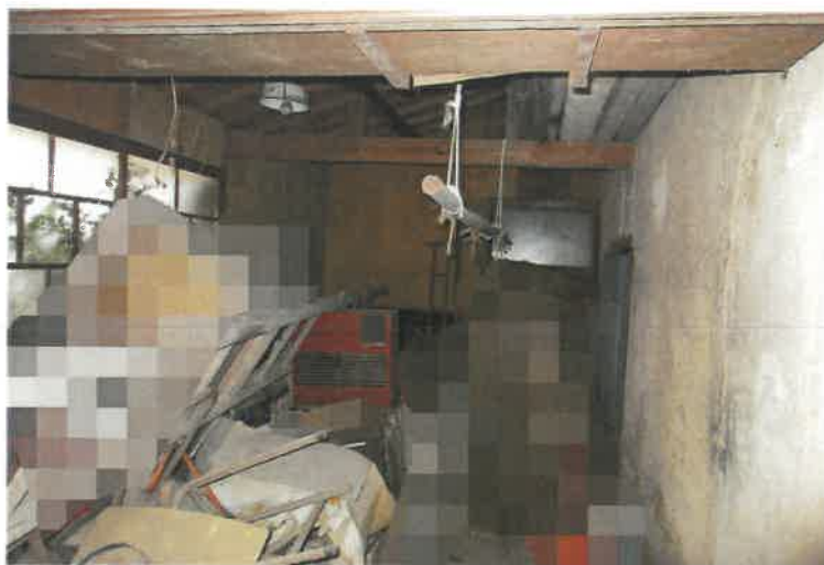
写真25 附属建物符号4・北側物置
