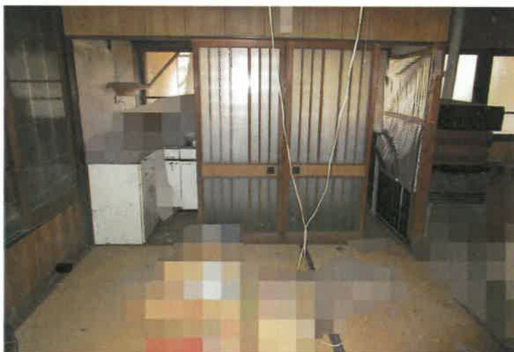
写真8 主建物・北東側土間
