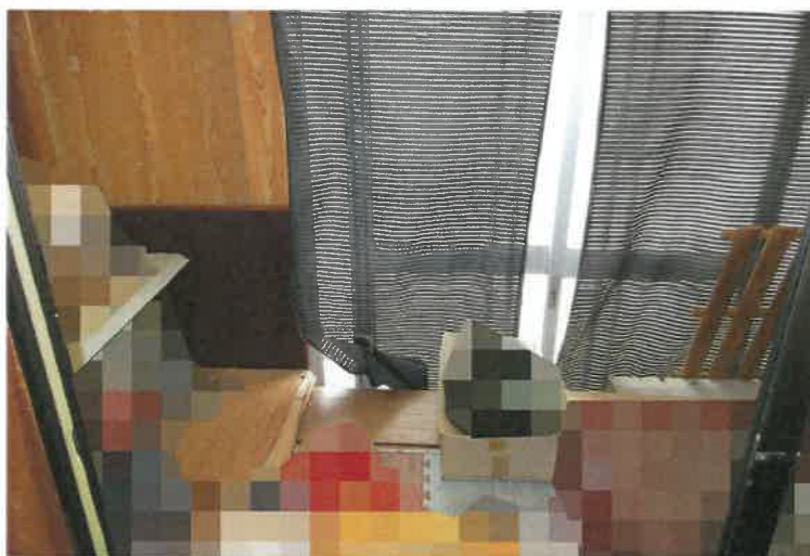
写真17 1階玄関2（未登記増築部分）
