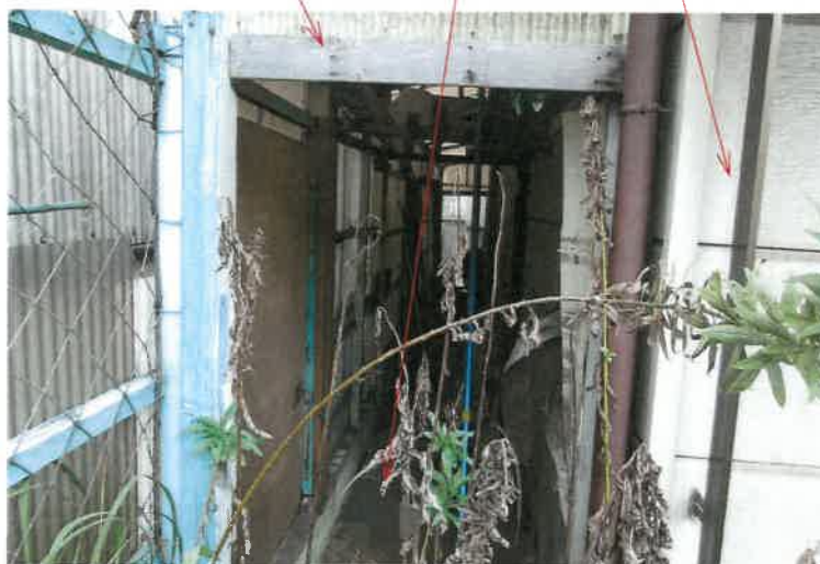
写真6 下屋 物件1 土地 物件2 建物（未登記増築部分）
