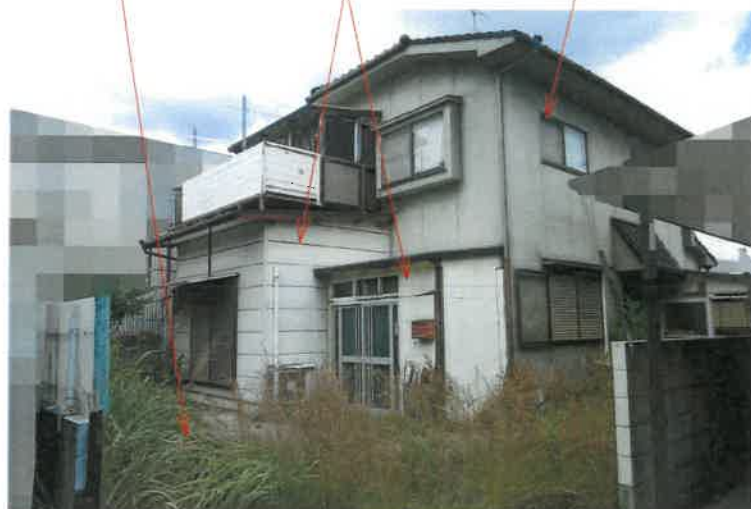
写真1 物件1 土地 未登記増築部分 物件2 建物
