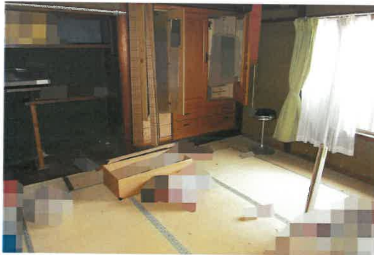
写真1 3 物件6主建物・2階和室8帖
