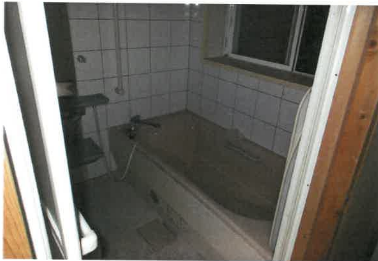
写真8 物件6主建物・1階浴室
