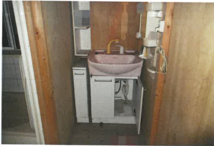
写真7 物件6主建物・1階洗面・脱衣室
