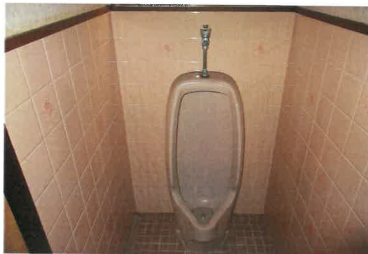
写真6 物件6 主建物・1階男性用トイレ
