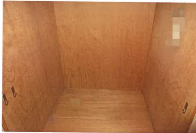
写真29 物件7建物・2階物入
