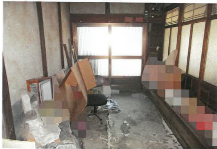
写真1 4 物件6附属建物符号1・1階土間
