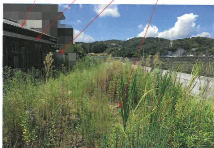
写真5 物件3建物 下屋 仮設物置 物件2土地
