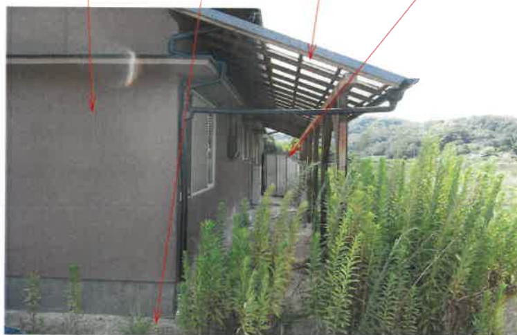
写真4 物件3建物 物件1土地 下屋 仮設物置
