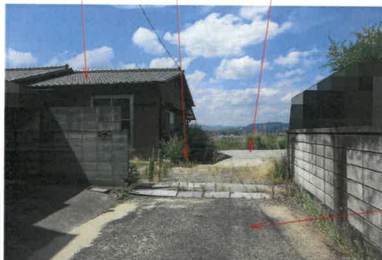
写真1 物件3建物 物件1土地 基礎跡箇所
