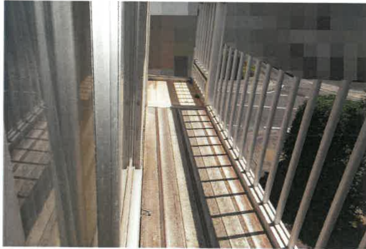
写真 2 2 2 階南側ベランダ
