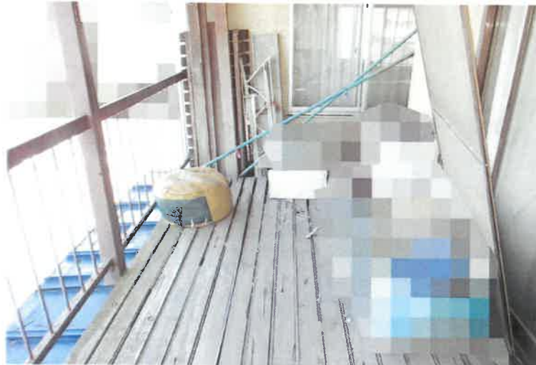
写真 2 3 2 階北西側ベランダ
