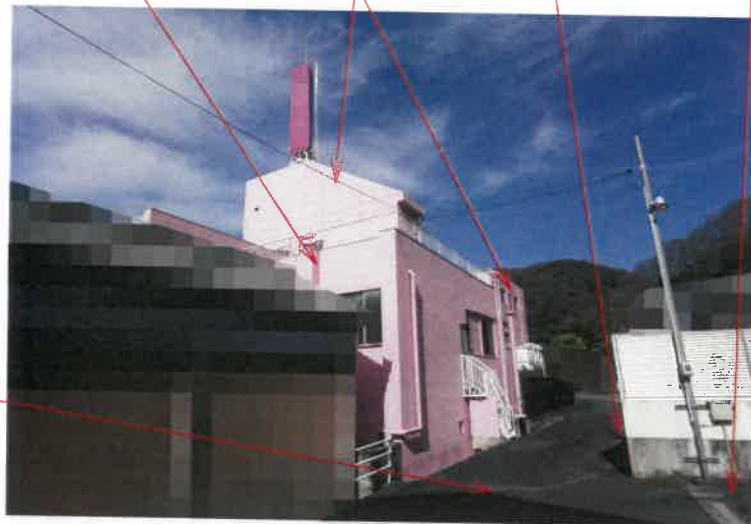
写真9 物件4 建物 物件2 主建物 物件6 土地 物件5 土地
