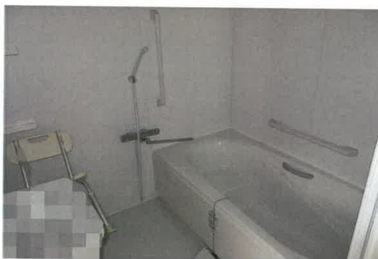
写真17 物件2主建物・1階浴室1
