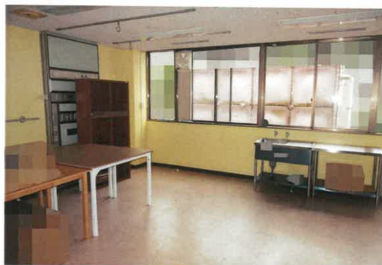
写真48 物件2主建物・2階食堂(215)
