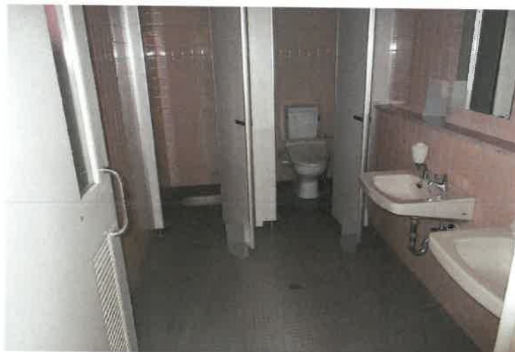
写真16 物件2主建物・1階南東側女性用トイレ
