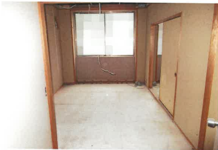
写真 6 8 物件 2 主建物・4 階寮室 1（寮室 3～5 は同型）
