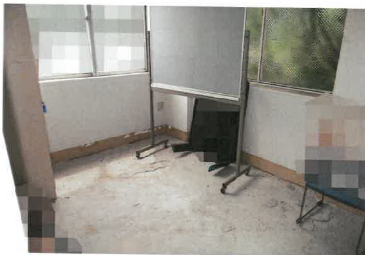
写真 1 1 7 物件 4 建物・3 階休憩室 3（床板なし）
