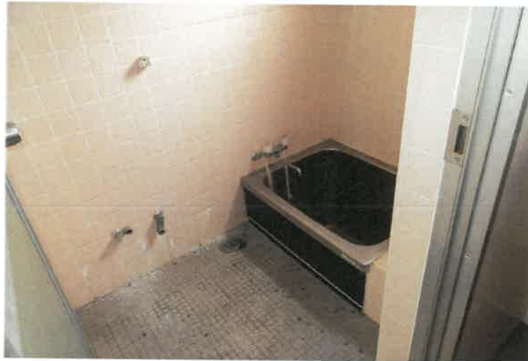
写真 6 7 物件 2 主建物・4 階浴室
