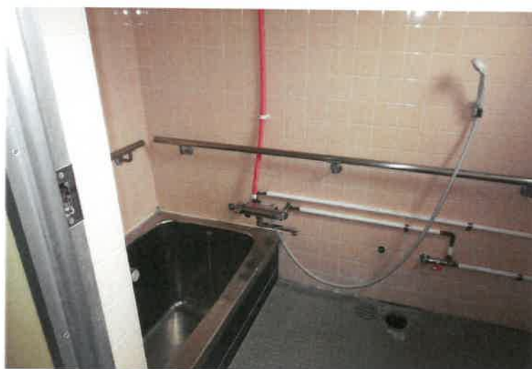
写真 4 2 物件 2 主建物・2 階浴室
