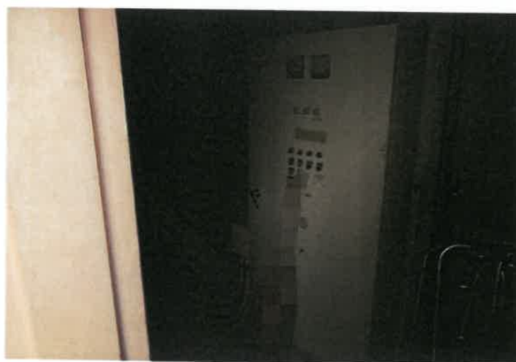
写真 9 3 物件 4 建物・1 階機械室 2
