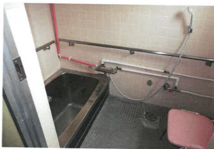
写真 5 6 物件 2 主建物・3 階浴室
