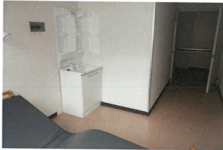
写真46 物件2主建物・2階居室(210)(211は同型)
