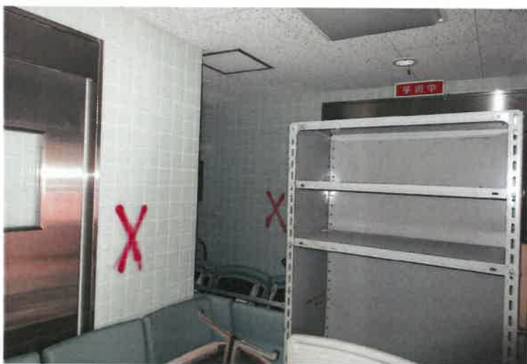
写真 7 8 物件 2 主建物・4 階手術準備ホール
