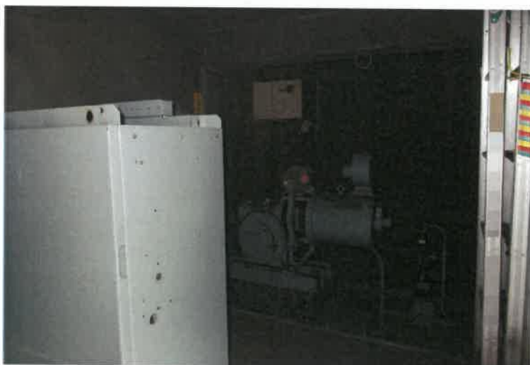
写真80 物件2主建物・5階E V機械室
