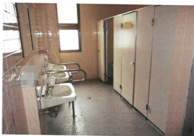
写真 5 7 物件 2 主建物・3 階女性用トイレ
