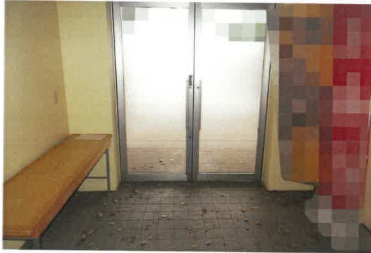
写真 8 5 物件 4 建物・1 階玄関
