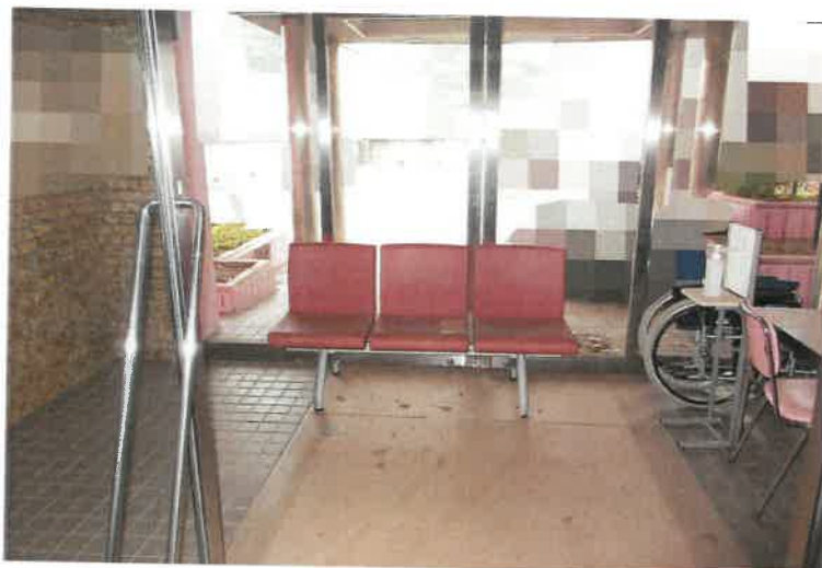
写真10 物件2主建物・1階風除室
