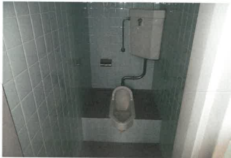
写真 2 2 物件 2 主建物・1 階休憩室横トイレ
