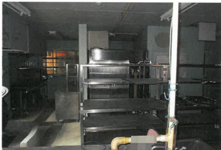
写真 1 9 物件 2 主建物・1 階厨房 1
