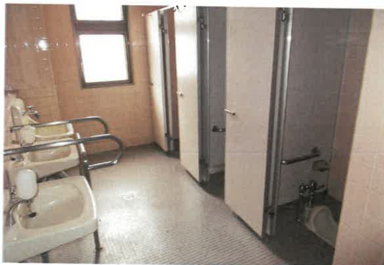
写真4 3 物件2主建物・2階女性用トイレ
