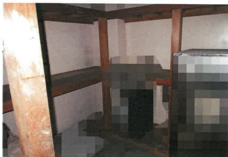
写真 2 4 物件 2 主建物・1 階倉庫 2
