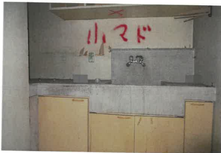
写真 3 1 物件 2 主建物・1 階倉庫 5 北側簡易キッチン部分（未完成）
