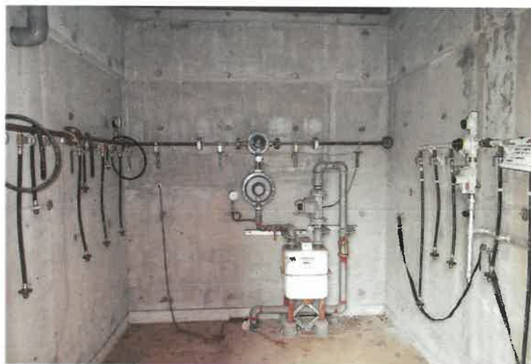
写真 8 2 物件 2 附属建物・倉庫 1
