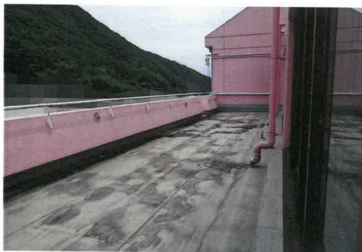
写真 7 5 物件 2 主建物・4 階屋上
