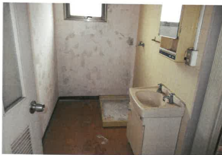
写真6 6 物件2主建物・4階洗面所
