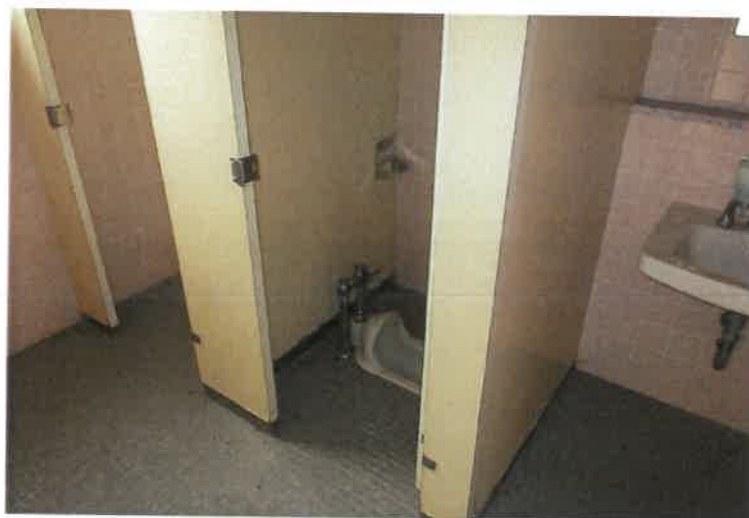
写真6 4 物件2主建物・4階西側トイレ
