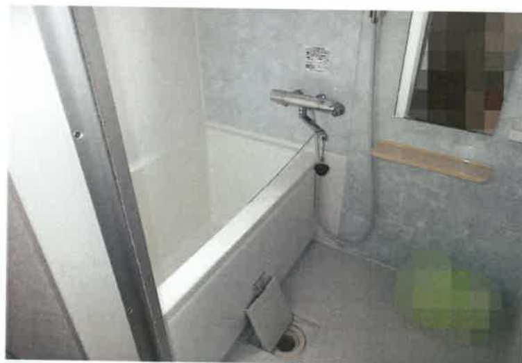
写真108 物件4建物・2階浴室
