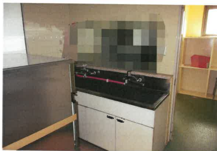
写真5 4 物件2主建物・3階洗面室
