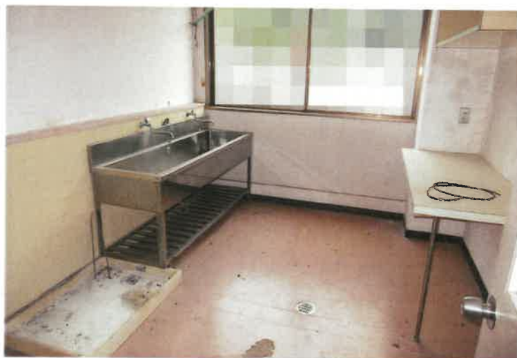
写真7 2 物件2主建物・4階洗濯室
