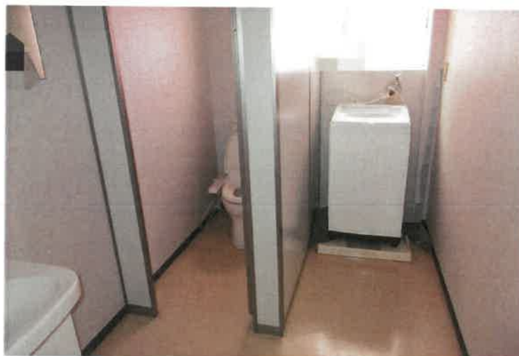
写真118 物件4建物・3階洗濯室
