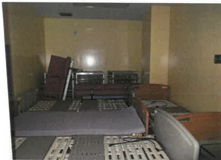
写真 2 8 物件 2 主建物・1 階男子更衣室
