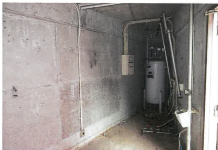
写真 8 3 物件 2 附属建物・倉庫 2
