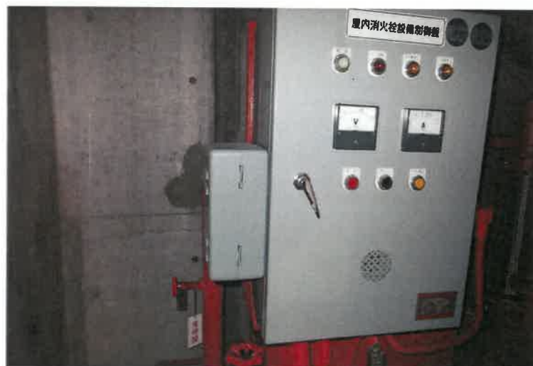
写真 2 3 物件 2 主建物・1 階倉庫 1
