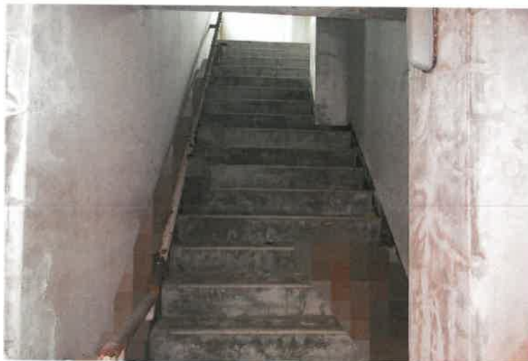
写真 9 7 物件 4 建物・1 階倉庫 4 北西側階段部分
