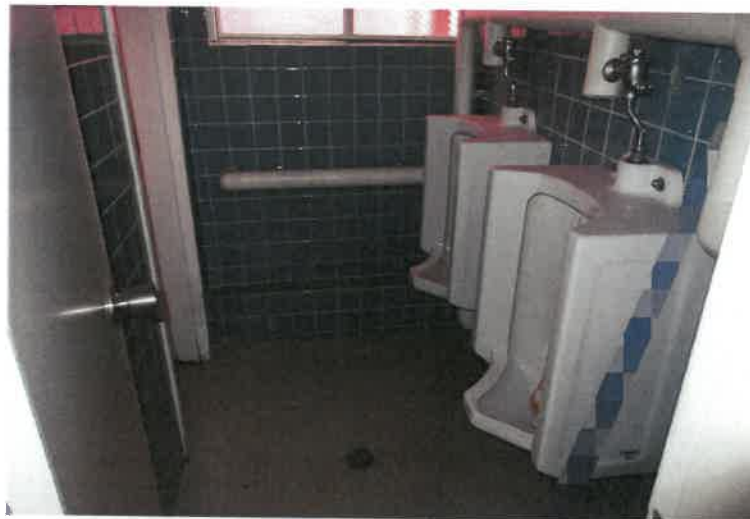
写真 8 7 物件 4 建物・1 階男性用トイレ
