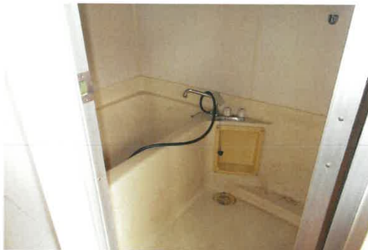
写真 7 6 物件 2 主建物・4 階更衣室西側浴室
