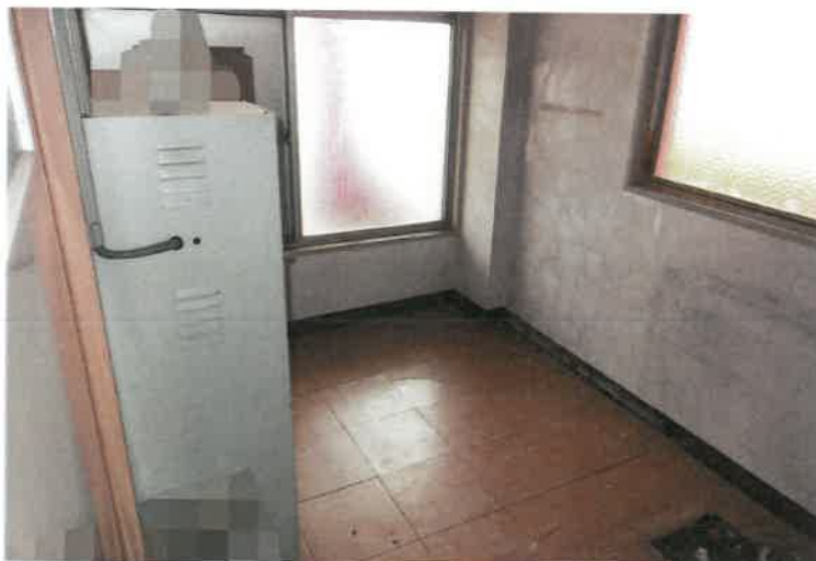
写真 9 4 物件 4 建物・1 階倉庫 1
