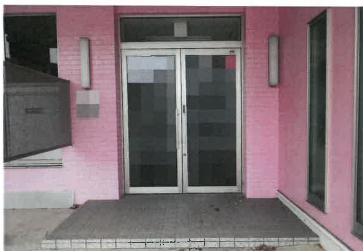
写真 8 4 物件 4 建物・1 階ポーチ
