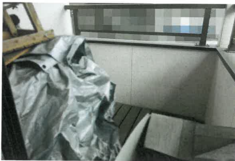
写真19 2階北東側ベランダ
