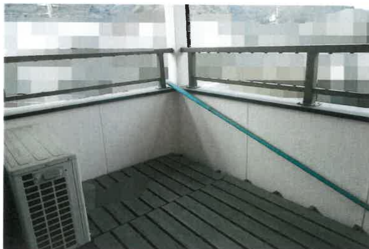
写真18 2階南西側ベランダ
