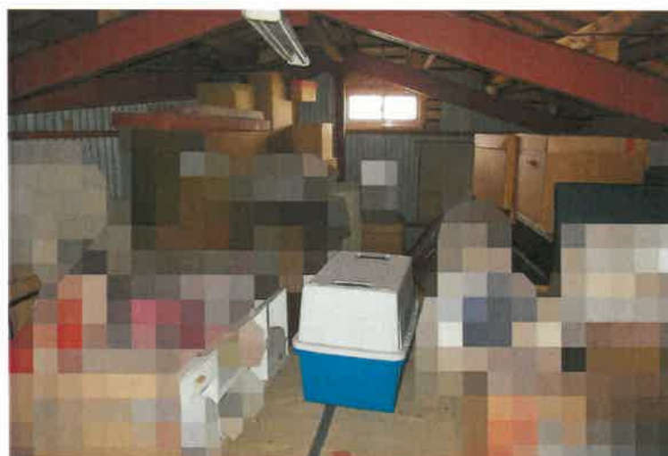
写真21 2階倉庫（増築部分）
