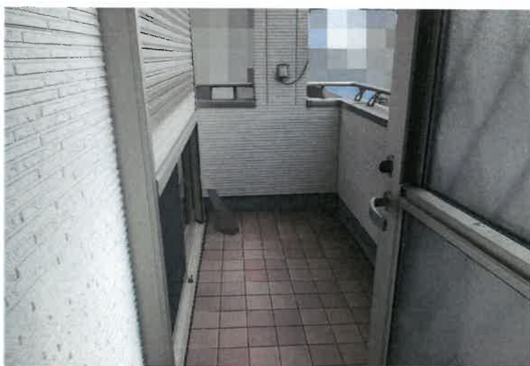
写真20 2階バルコニー
