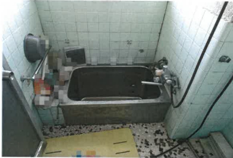
写真11 主である建物内の状況
