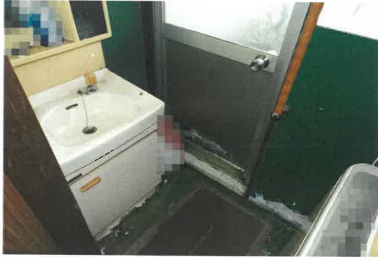
写真10 主である建物内の状況
